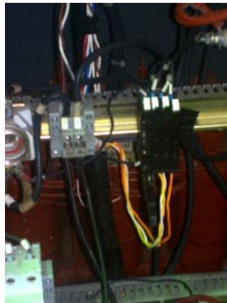
Figura 6.18 Fusibles de protección para alta y baja tensión
