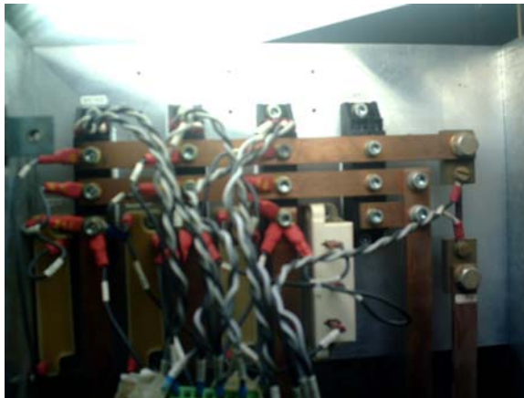
Figura 6.20 Detalle del puente rectificador con tiristores
