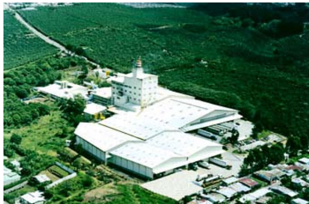
Figura 1.1. Planta de producción de Irex de Costa Rica, ubicada en Concepción de Tres Ríos
