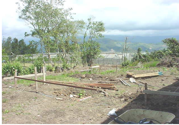
Figura 4. Terreno aplanado e inicio de la construcción
