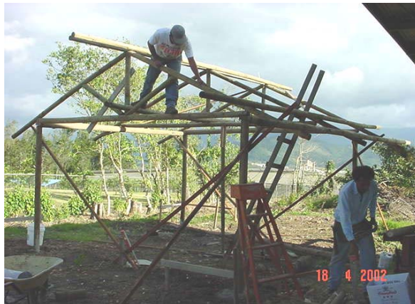
Figura 6. Levantamiento de la estructura
