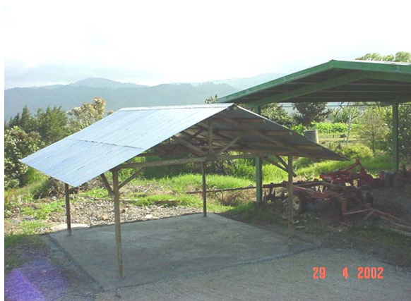
Figura 7. Planta piloto para la elaboración del compost
