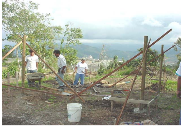
Figura 5. Levantamiento de los pilares
