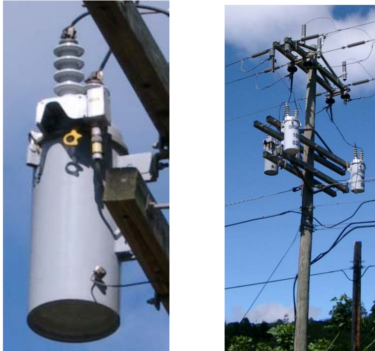
Figura 1.1 Ejemplo de disposición de los recloser en la red de distribución (Ubicados en Guadalupe de Tarrazú)
