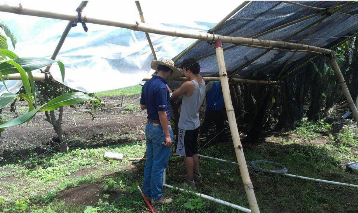
Figura 22. Estudiantes de la carrera de Ingeniería en Agronegocios en el proceso de construcción. Foto propia.
