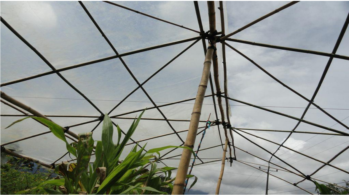
Figura 17. Estructura del techo sin plástico. Foto propia.
