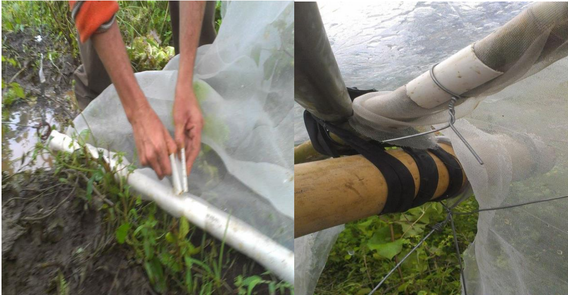
Figura 19. Detalle de las pegas del plástico con la malla antiáfidos y la estructura de bambú. Foto propia.
