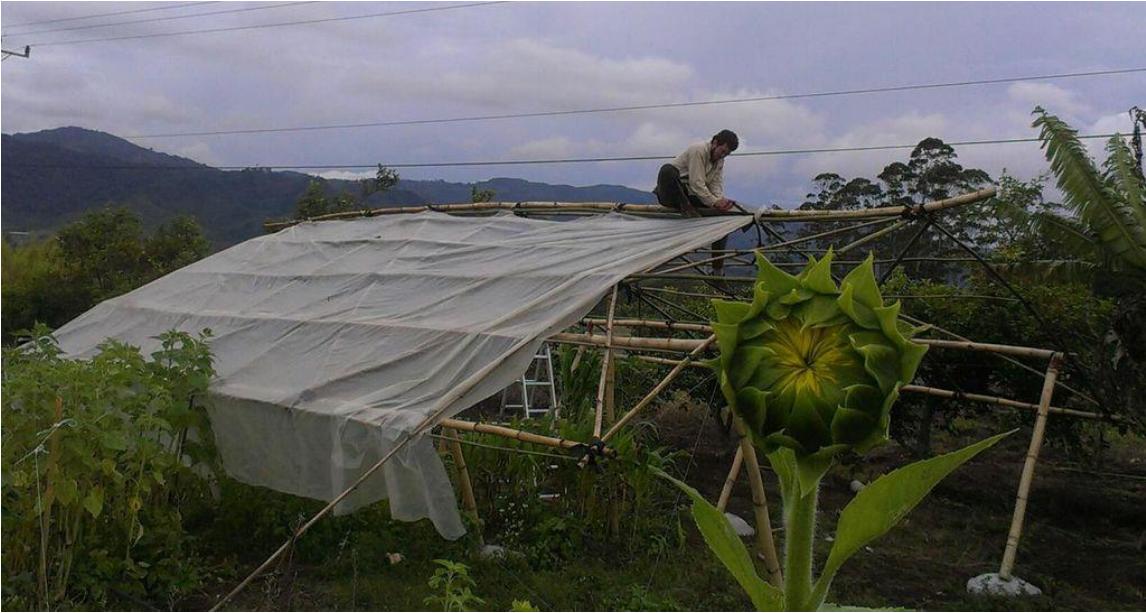
Figura 16. Colocación de los plásticos. Foto propia.
