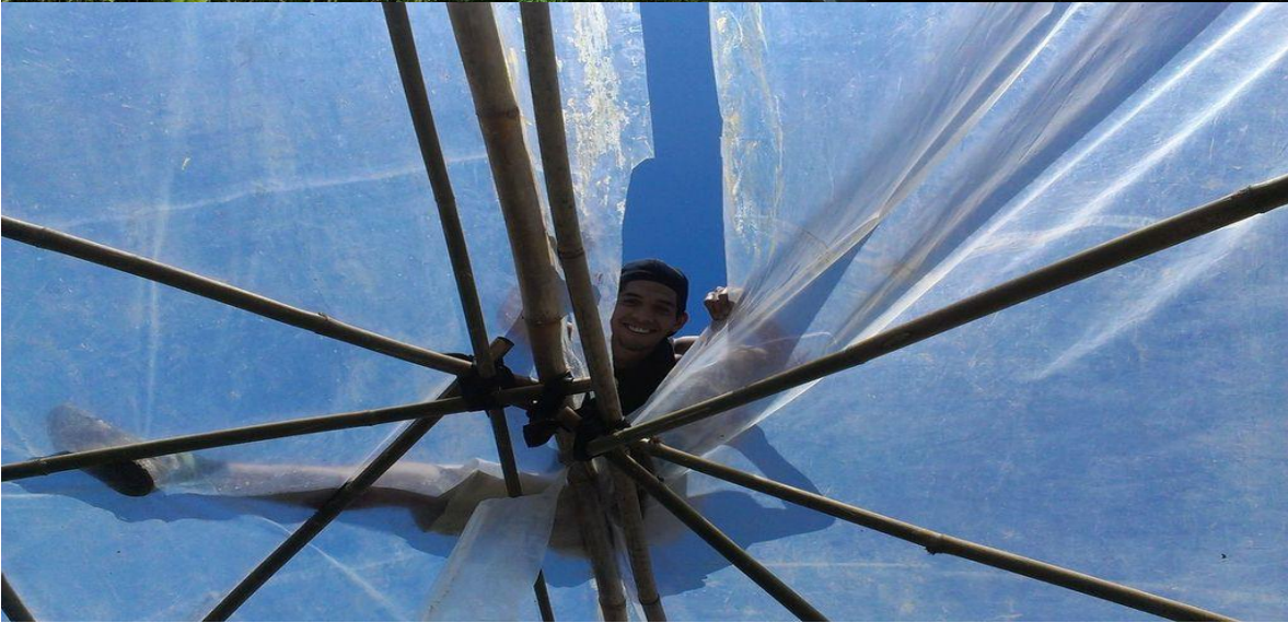
Figura 20. Pega de techo con goma de contacto. Foto propia.
