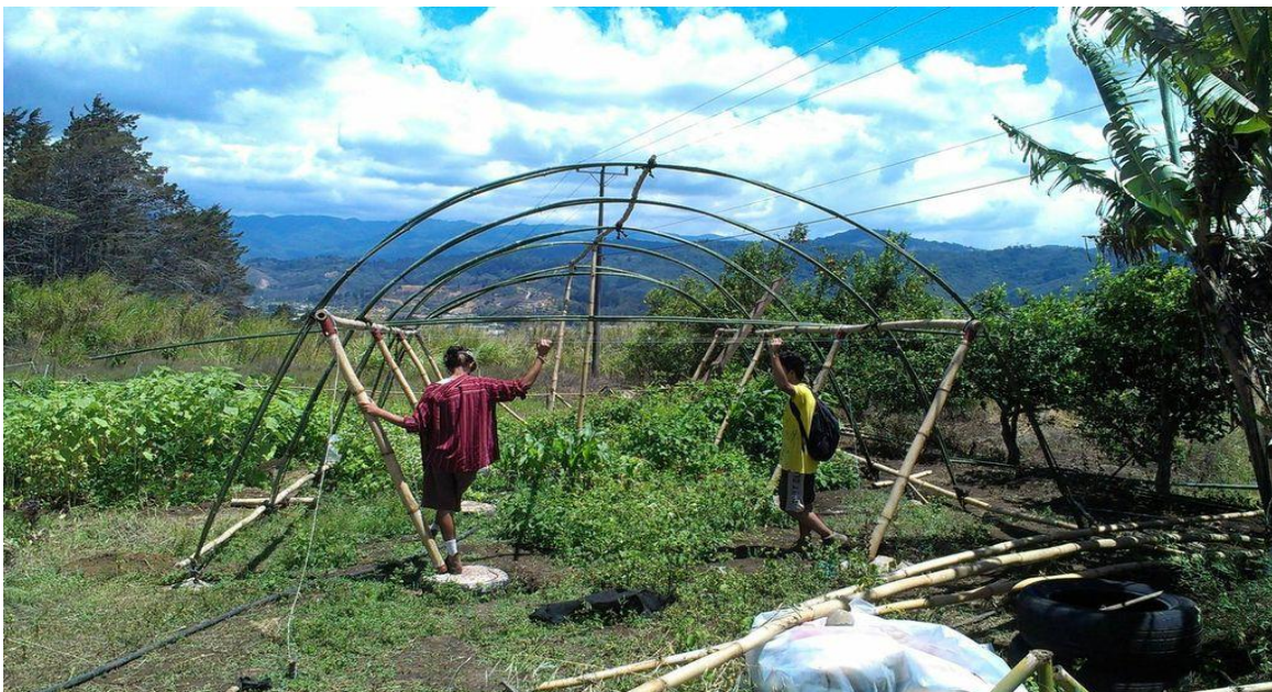
Figura 13. Detalle del primer modelo de arco propuesto para el techo del invernadero. Foto propia.
