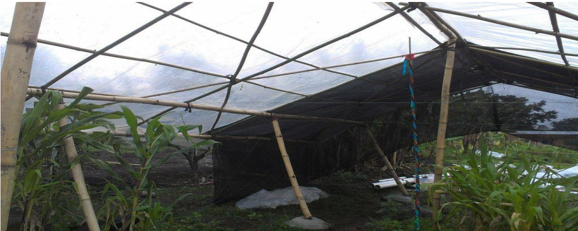
Figura 21. Estado del invernadero terminada. Foto propia.
