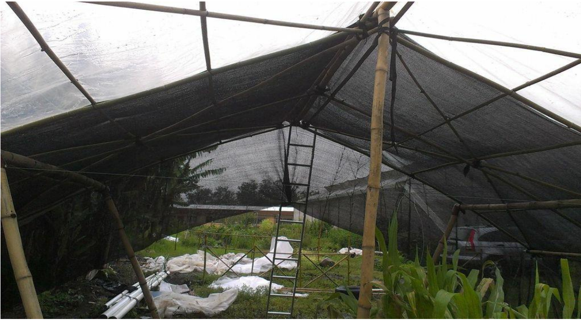
Figura 18. Detalle de la colocación del sarán en el invernadero. Foto propia.
