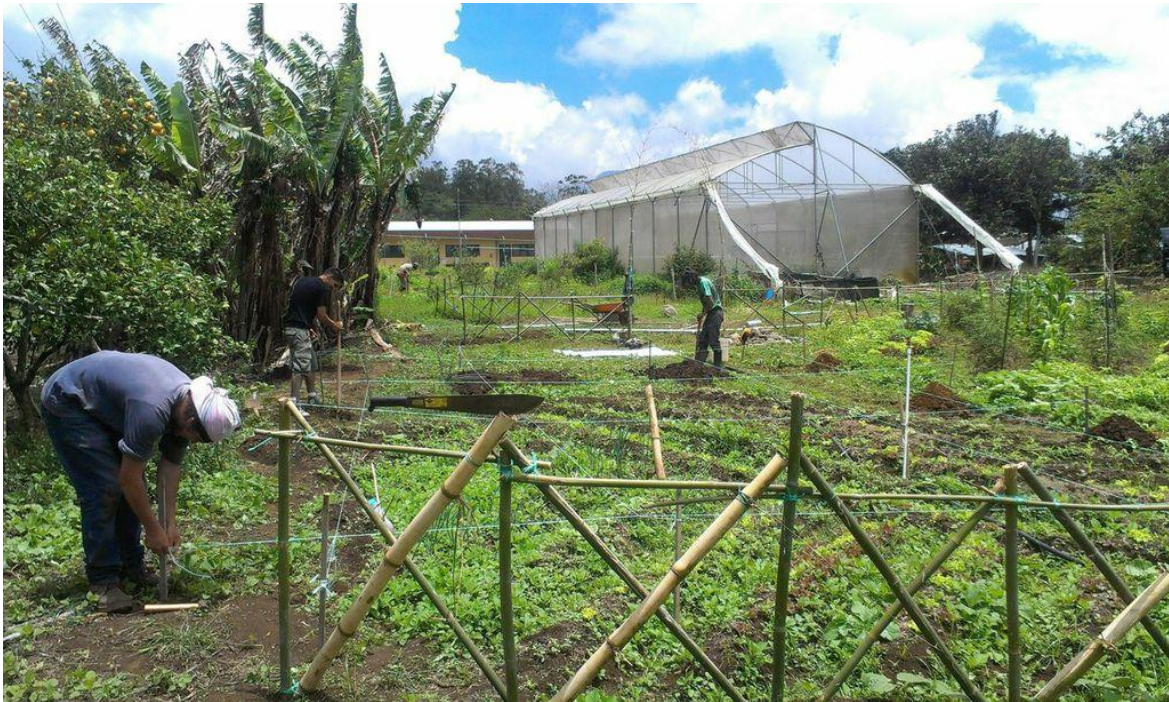
Figura 11. Etapa inicial de construcción. Foto propia.
