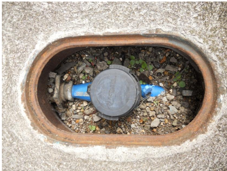
Figura 22. Medidor de agua potable sin tapa y con tapón en la carátula.
