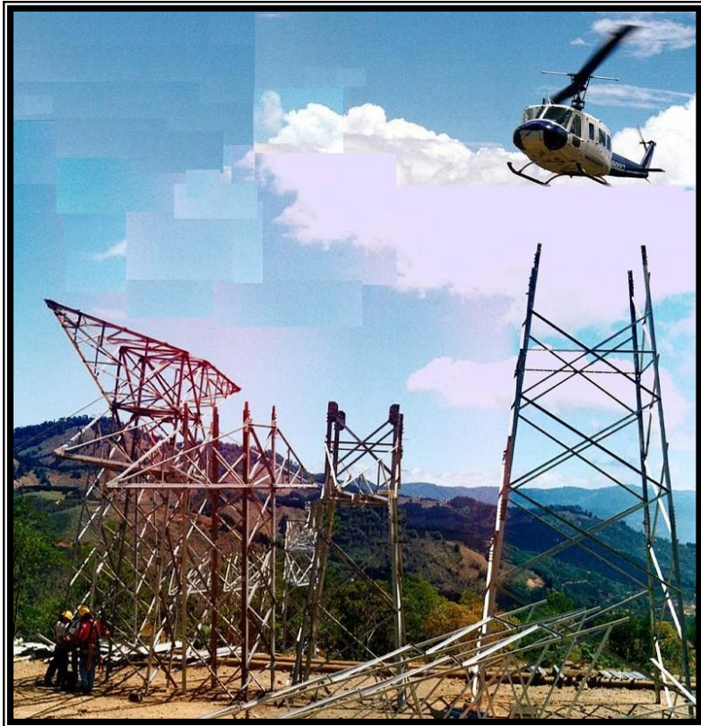
Figura 9. Uso de un helicóptero para el transporte de torres, en la línea de transmisión Lindora-Parrita
