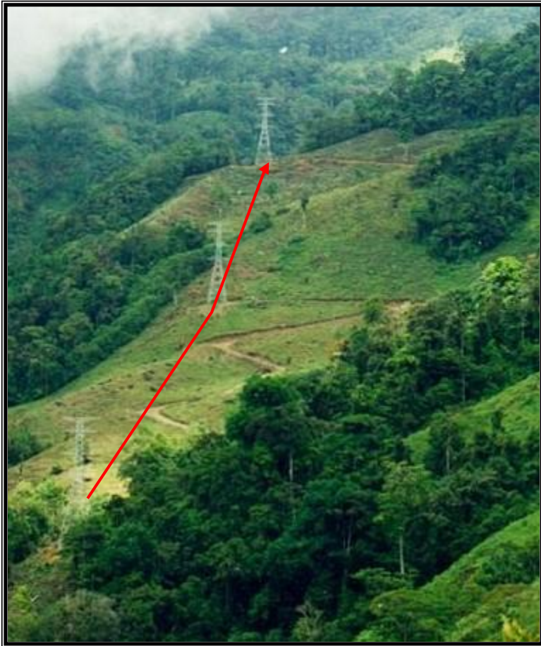
Figura 6. Instalación de torres en áreas despejadas
