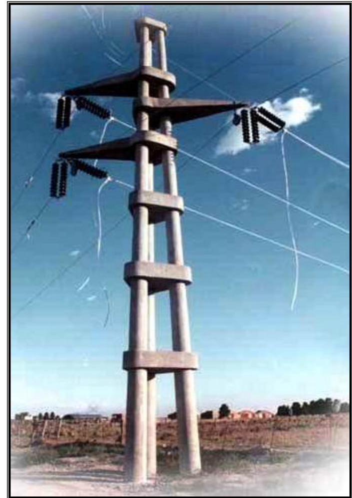
Figura 7. Torres tubulares de menor impacto ( 5 \text{ m}^2 ) utilizadas en Bolivia-Suramérica
