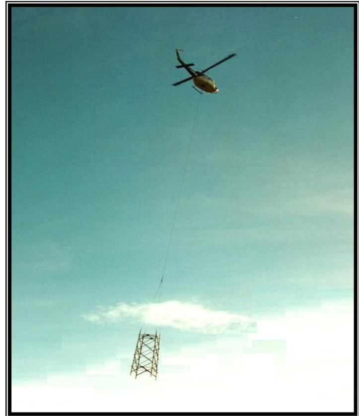
Figura 10. Transporte de torres con helicóptero
