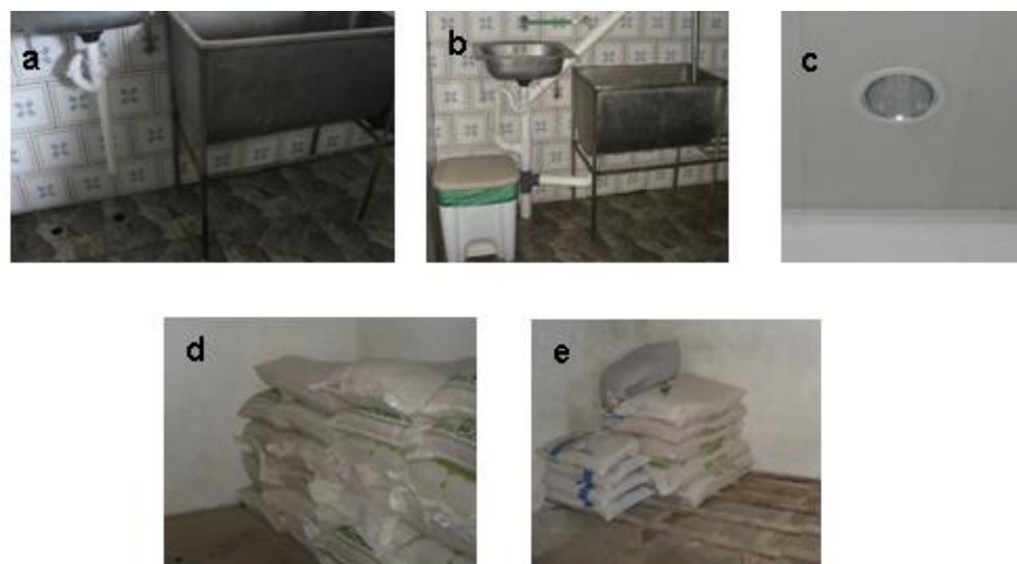
Figura 25. Mejoras realizadas en la lechería número trece. a) y b) lavatorio y tina del cuarto de almacenamiento y enfriamiento de la leche, sin y con tubos para drenaje de agua respectivamente y basurero, c) protectores al sistema de iluminación del cuarto de almacenamiento y enfriamiento de la leche, d) y e) sacos de alimento sin y con tarima respectivamente.
