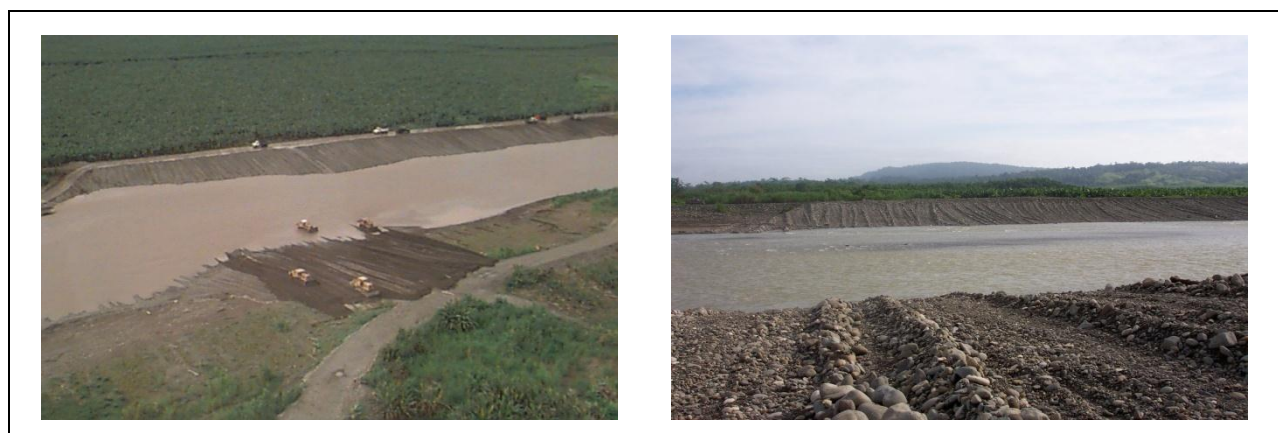
Figura 3.10. Proceso de limpieza del cauce y mantenimiento de los diques, río Estrella. Fuente: Casasola, R. 2002
