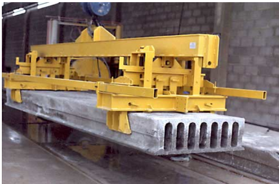
Figura 8. Desmolde de los elementos
