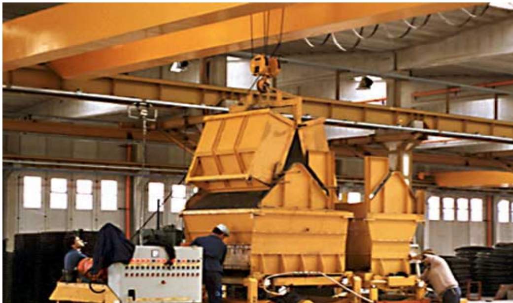
Figura 6. Colocación del concreto en la máquina vibro-compactadora por medio de grúas internas.
