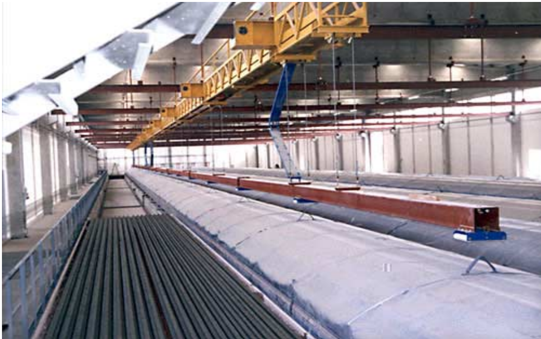
Figura 7. Colocación de lonas sobre las pistas de producción para evitar fisuramiento de los elementos por pérdida de agua
