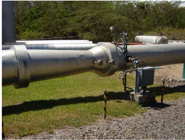
Figura 1.1. Ubicación del tubo Venturi
