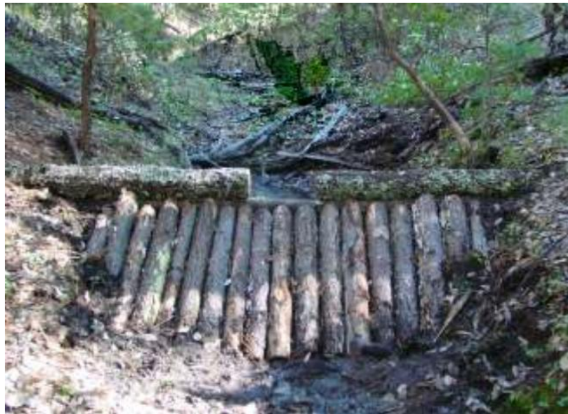
Figura 5. Dique construido a base de troncos.
