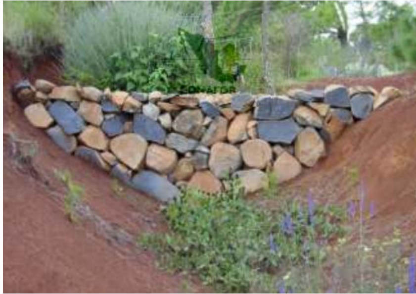
Figura 6. Dique construido a base de piedra.
