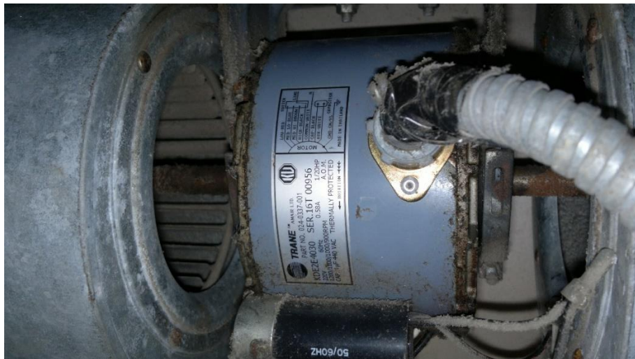
Fotografía 7.4 Motor FanCoil, Serie MCD, 12 000 Btu.
