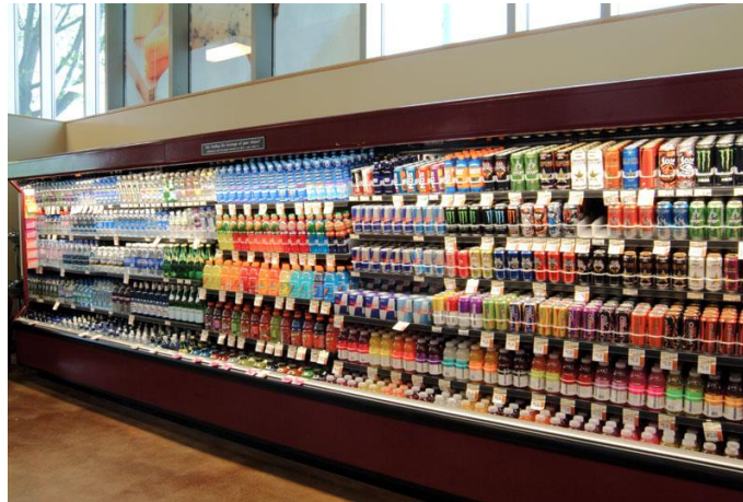
Figura 5.1. Gabinete o mueble de exhibición refrigerado modelo D5X de Hussmann
