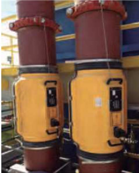
Figura 23. Caudalímetro de concreto, tipo Sonar.
