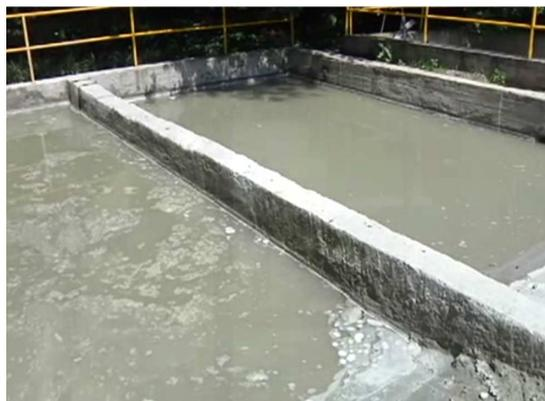
Figura 35. Ejemplo grafico de un tanque de tratamiento de agua en una planta de concreto. Sedimentador – Desarenador. Fuente: <http://odisa.com/>
