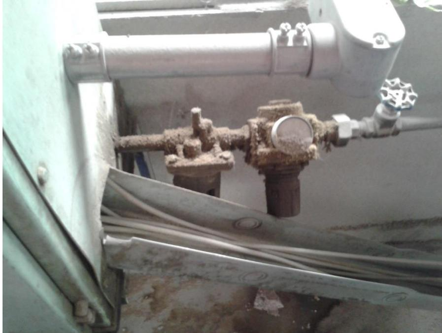
*Figura 4-3. Regulador y filtro en panel neumático horno 3.*
