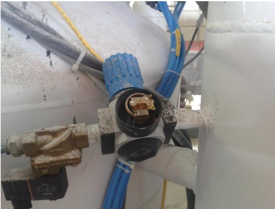
*Figura 4-2. Regulador de presión en sistema de transporte de polvo*
