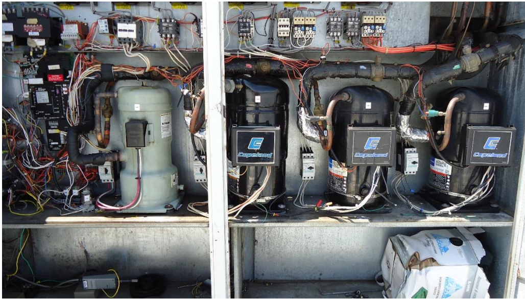
Figura4-6 Compresores rotatorios presentes en el equipo
