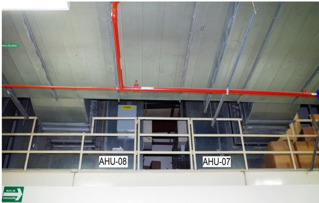
Figura 4-8 Disposición de las manejadoras
