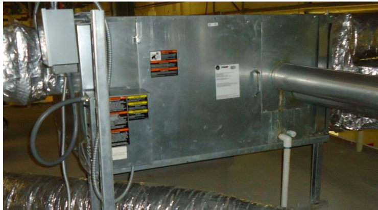
Figura 3-18 Manejadora de aire
