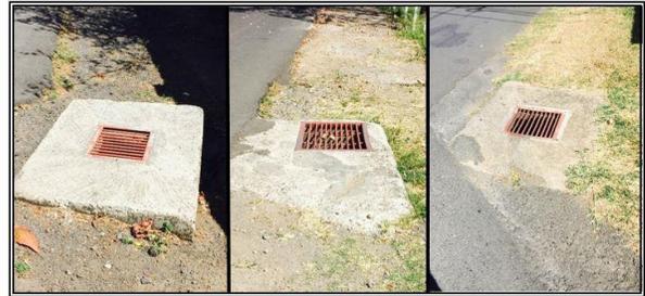
*Figura 1. Condiciones actuales de los pozos colectores en sitio.*
