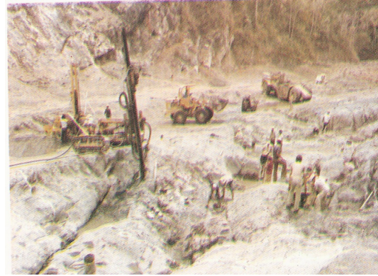
Figura 32 Limpieza manual de tierra y fragmentos en la fundación rocosa, antes de comenzar la construcción de la presa.
