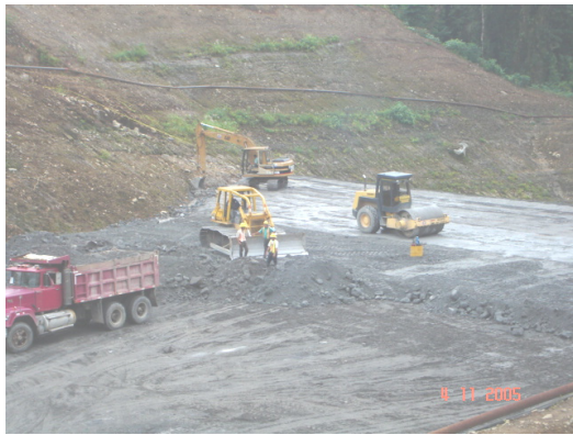
Figura 11. Maquinaria utilizada en construcción de dique para el embalse (P. H. Cariblanco).
