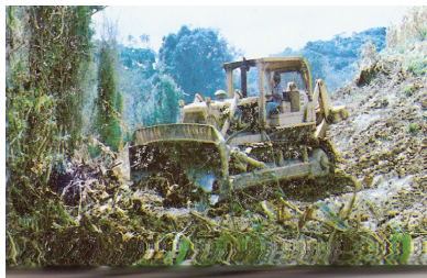
Figura 30 Labores iniciales de deforestación y limpieza de fundación de una presa.
