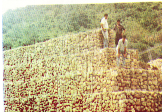
Figura 34 Presa de gaviones en construcción.
