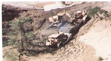
Figura 31 Excavación de barro, materia orgánica y suelos sueltos en la fundación de una presa.
