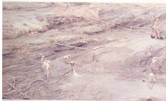
Figura 33 Limpieza final de la fundación rocosa con chorros de agua a presión antes de iniciar la construcción del terraplén de una presa.
