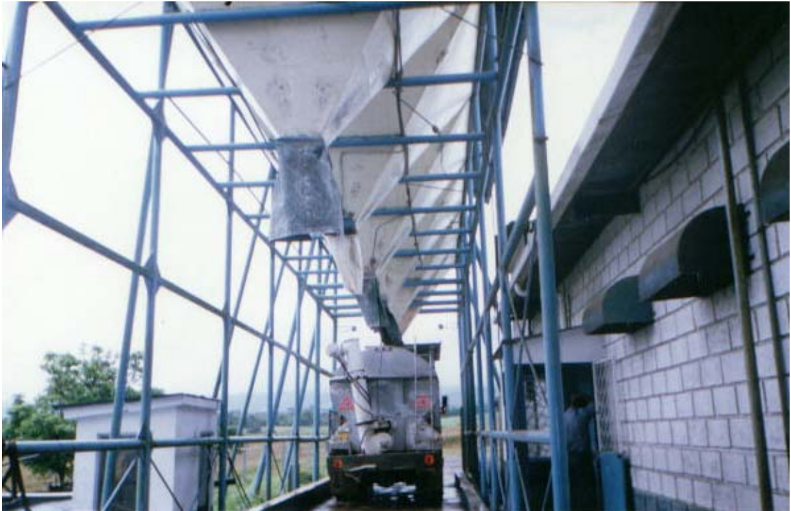
Figura 5. Traslado del producto terminado a granel. Alimentos del Norte, Propokodusa, Santa Rita, Grecia, 2002.
