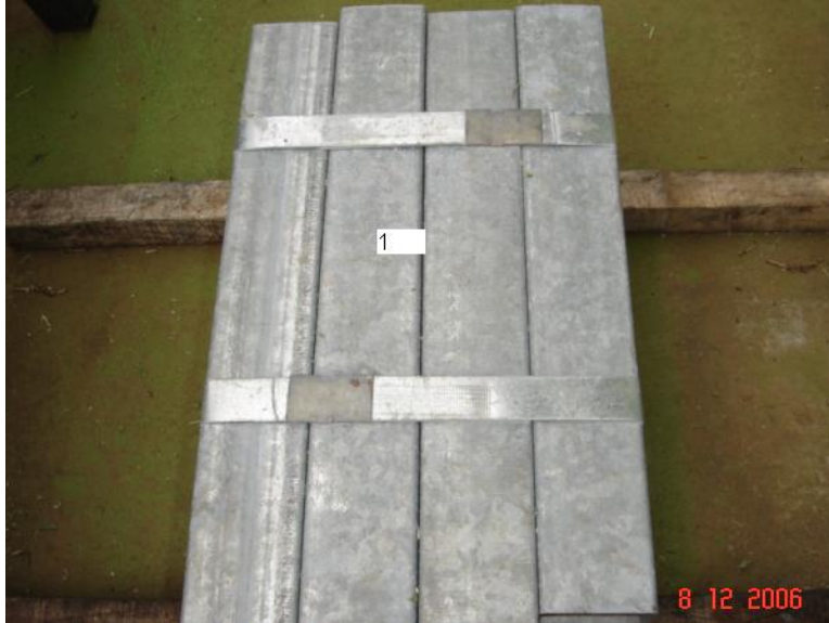
Figura 3.14: formación de corrosión blanca en los sectores externos del paquete de tubos.
