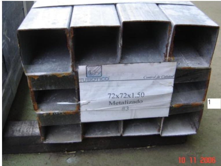
Figura 3.9: formación corrosión (herrumbre) en los bordes de corte de los tubos
