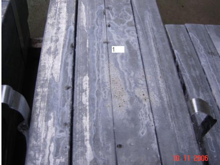
Figura 3.11: Formación de oxidación blanca y herrumbre en las caras de los sectores internos del paquete de tubos.
