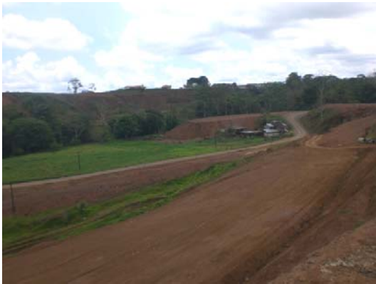
Figura 5. Tramo para obra carretera San Carlos-San Ramón. En la Figura 6 se muestra un sitio de botadero del proyecto carretera San Carlos-San Ramón, ubicado al noroeste del sitio a ubicar el embalse, aproximadamente a 200 metros, mostrando alteración de la geomorfología.
