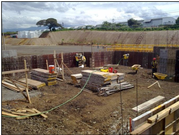
Figura 13. Vista general del módulo 2.
