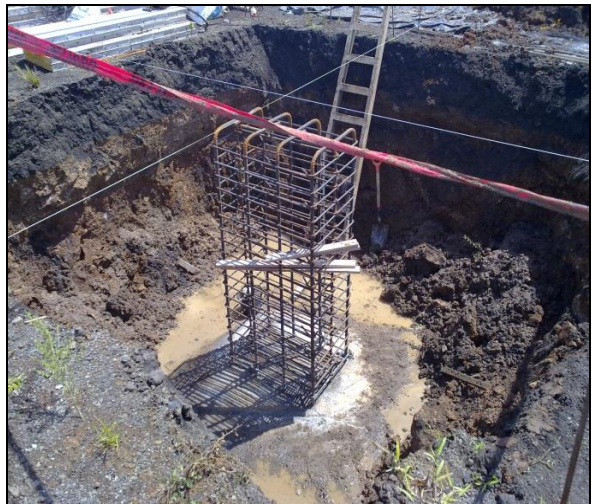
Figura 9. Pedestal del eje 7C de la nave central, listo para ser encofrado.
