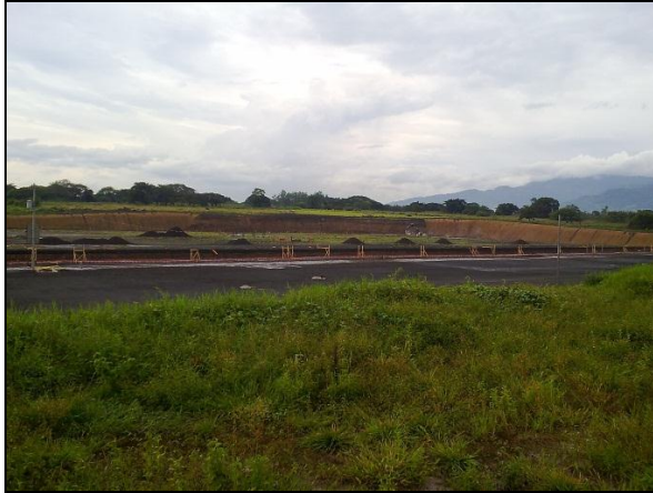
Figura 3. Vista del sector sureste del proyecto.
