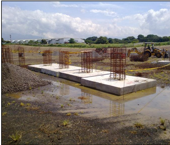
Figura 7. Stock de placas prefabricadas en la nave central listas para ser colocadas.
