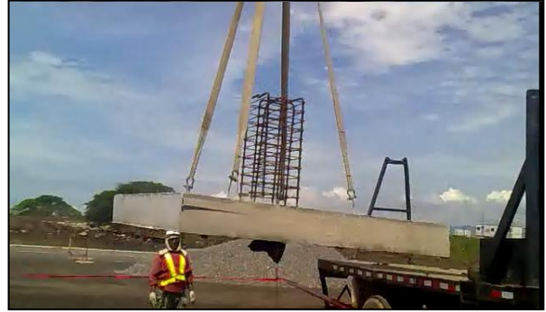
Figura 8. Montaje de placa prefabricada por medio de grúa móvil.
