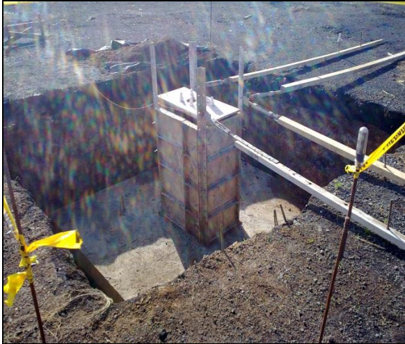
Figura 10. Pedestal del eje 8D completamente encofrado.
