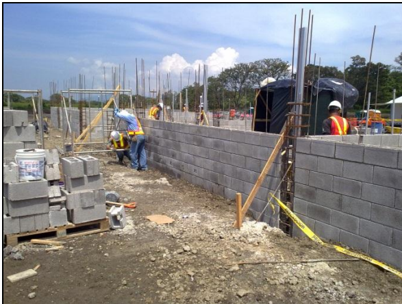
Figura 6. Acabado de muros de mampostería sisados.
