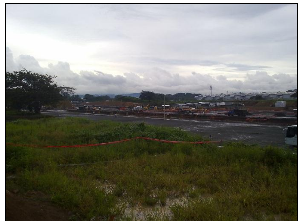
Figura 2. Vista del sector noroeste del proyecto.
