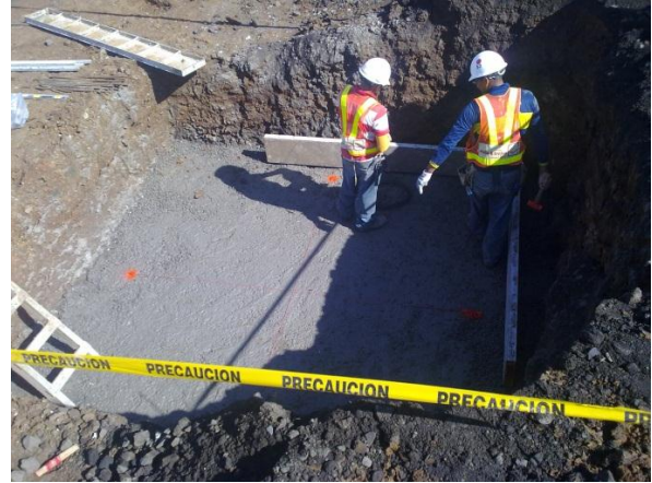
Figura 12. Encofrado de placa del eje 7A de la nave central.
