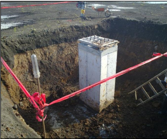
Figura 11. Pedestal colado y listo.
