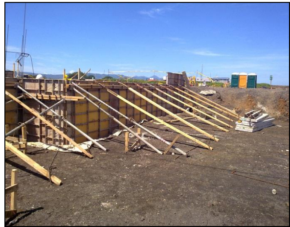
Figura 15. Arriostres de soporte para muro de retención.
