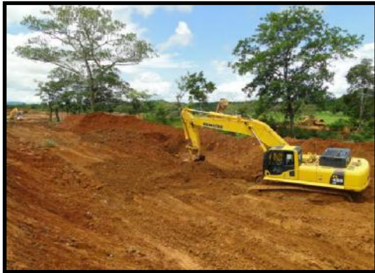
Imagen 10. Zona de excavación, cambio de volumen del material
