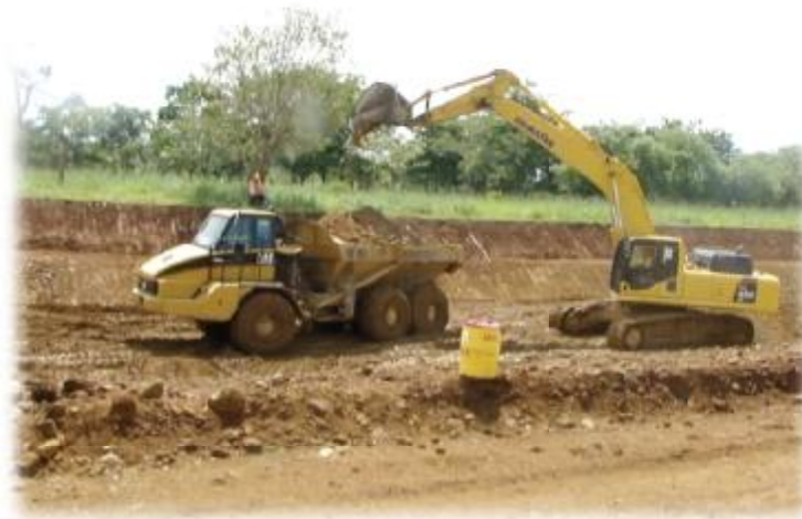
Imagen 2. Trabajos en canal de conducción.
