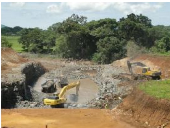
Figura 3. Vista general excavación realizada en casa de máquinas
