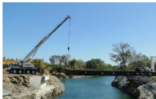
Figura 14. Colocación de puente provisional, PHSL
