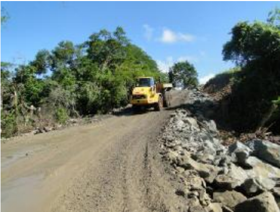
Figura 9. Mejoramiento de caminos con roca proveniente de voladura, PHSL
