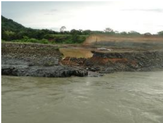
Figura 16. Ataguía aguas abajo destruida, PHSL
