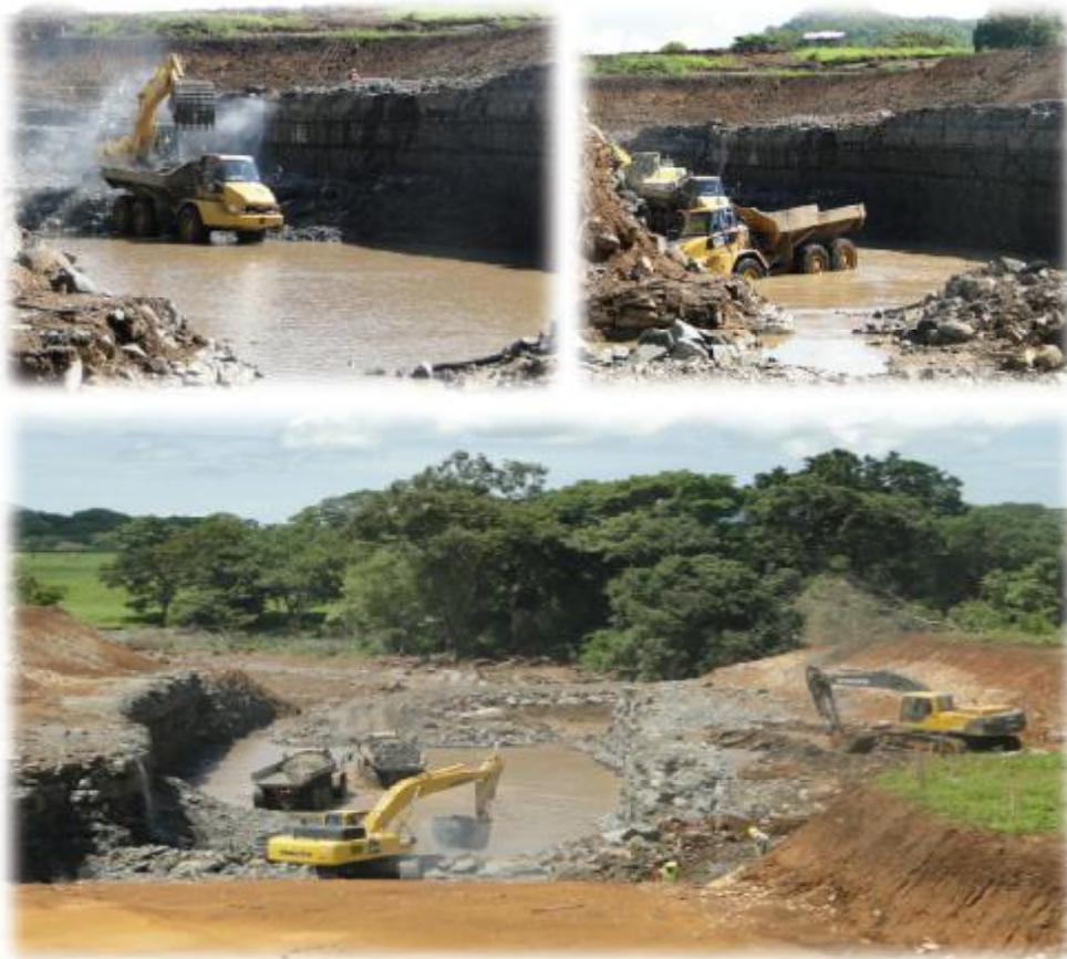
Imagen 1. Excavación en roca, canal de desfogue.
