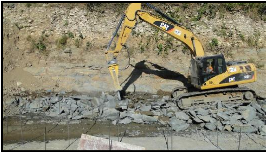
Imagen 7. Desagregación previa con martillo hidráulico, PHSL
