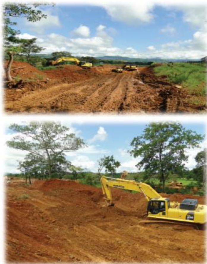
Imagen 1. Zona de excavación.
