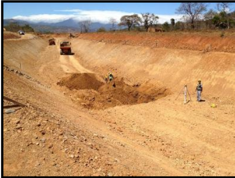
Imagen 6. Equipo de topografía, PHSL
