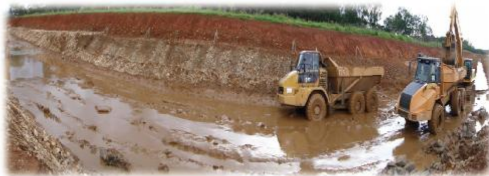
Imagen 3. Vista panorámica de la zona de excavación.
