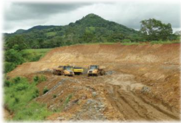
Imagen 2. Vista general sitio de excavación.
