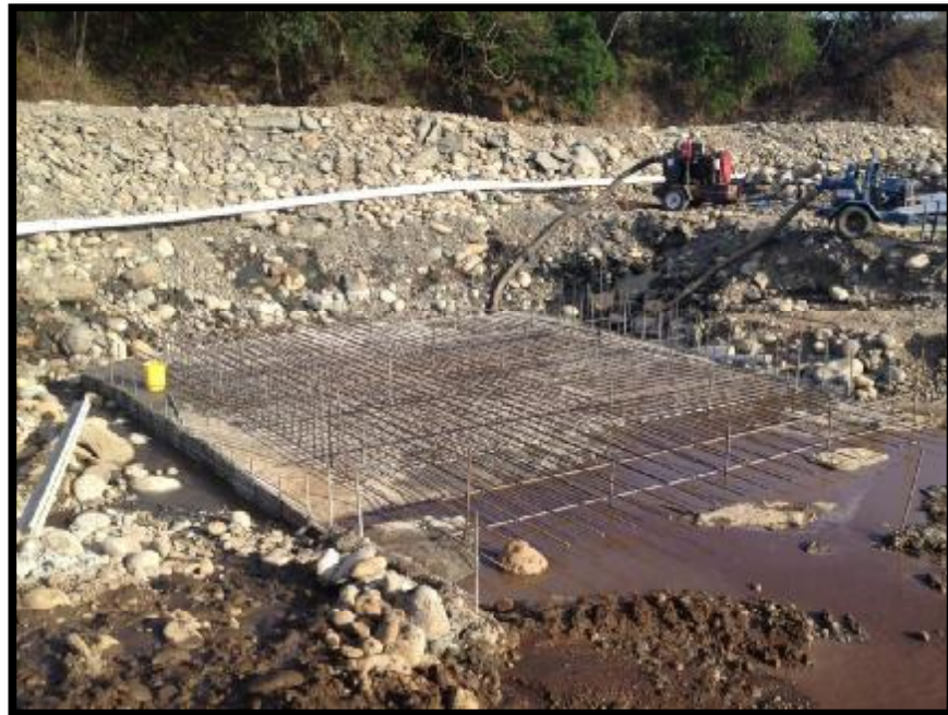
Imagen 5. Abatimiento del agua por medio de bombeo, PHSL
