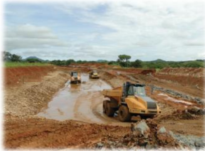
Imagen 1. Vista general de la zona de excavación.
