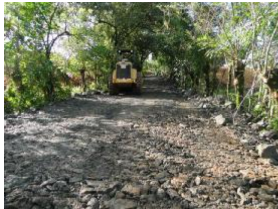
Figura 11. Equipo de Saret en mantenimiento del camino público
