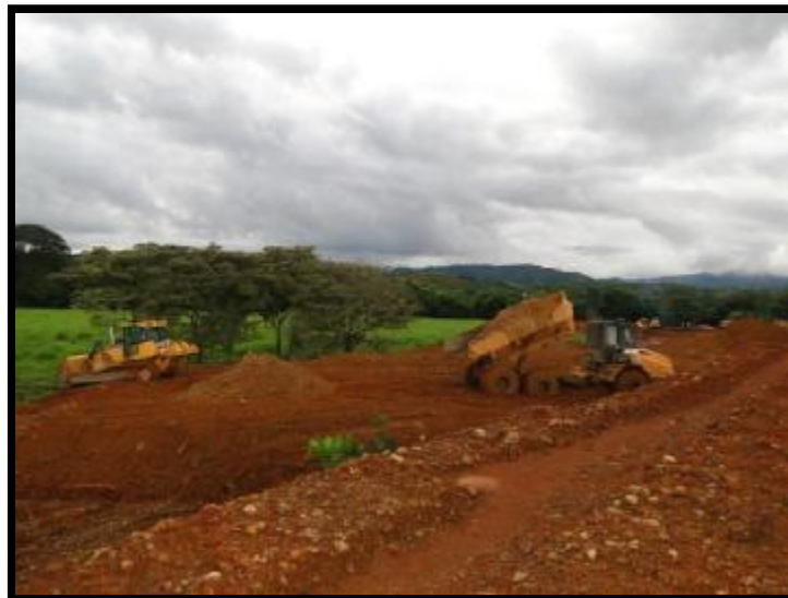
Imagen 9. Descarga y extendido del material excavado, PHSL
