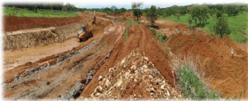
Imagen 2. Vista general excavación canal de conducción.
