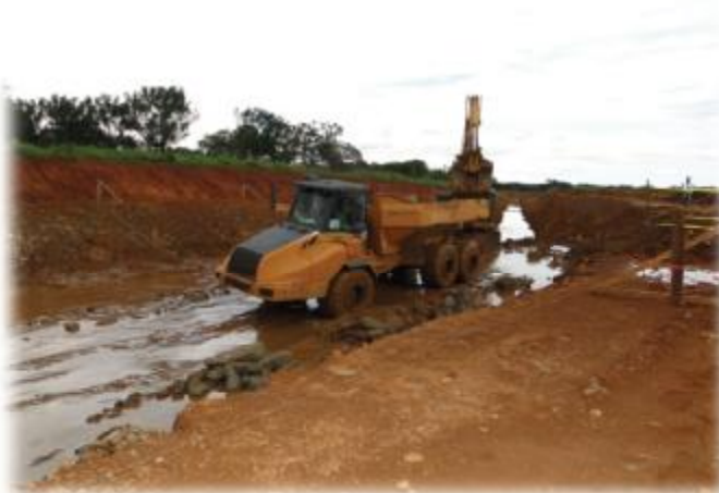
Imagen 2. Equipo de acarreo en proceso de carga.
