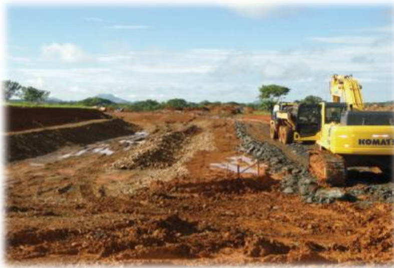
Imagen 1. Mejoramiento de caminos, canal de conducción.
