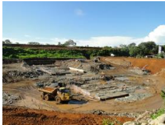
Figura 4. Vista de excavación realizada en el sector de la presa, PHSL
