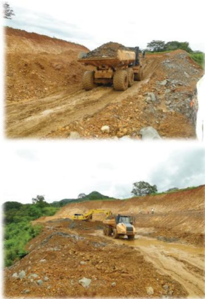
Imagen 1. Vista general sitio de excavación.
