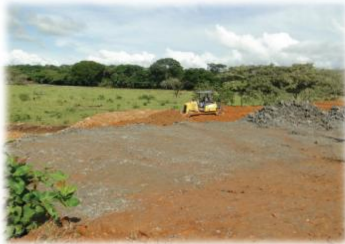
Imagen 3. Tractor expandiendo material en el botadero.
