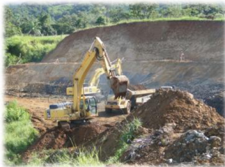
Imagen 1. Excavación estructura de toma.
