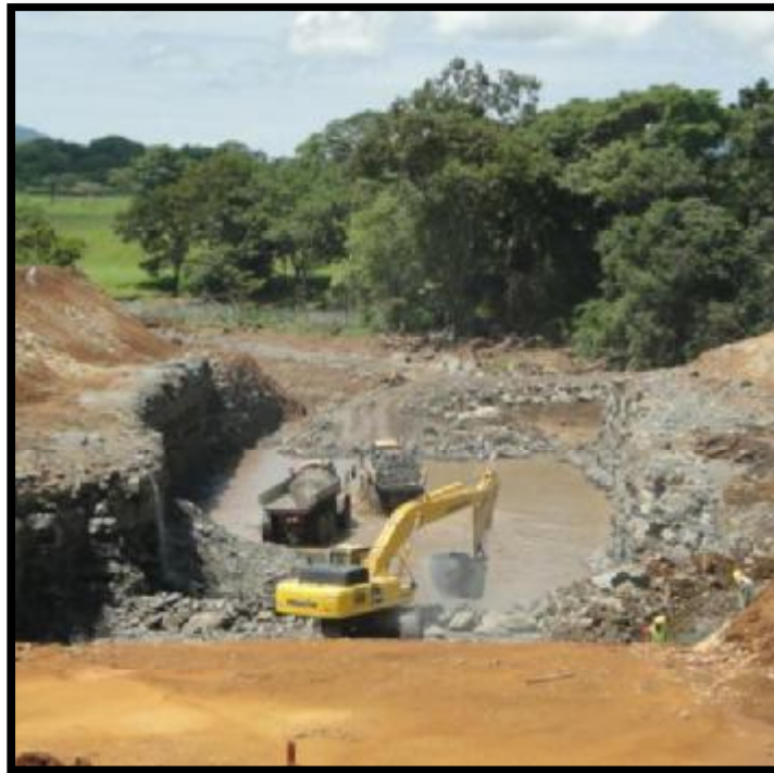
Imagen 8. Carga y transporte del material, PHSL
