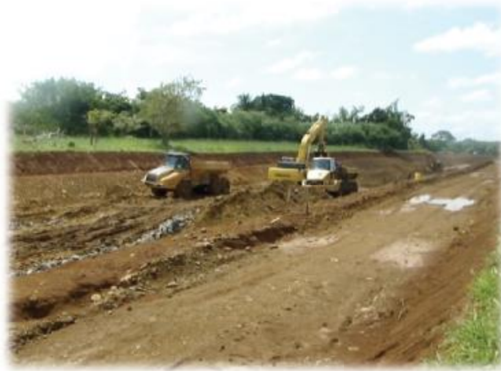
Imagen 3. Excavación en arcilla y aluvión, canal de conducción.
