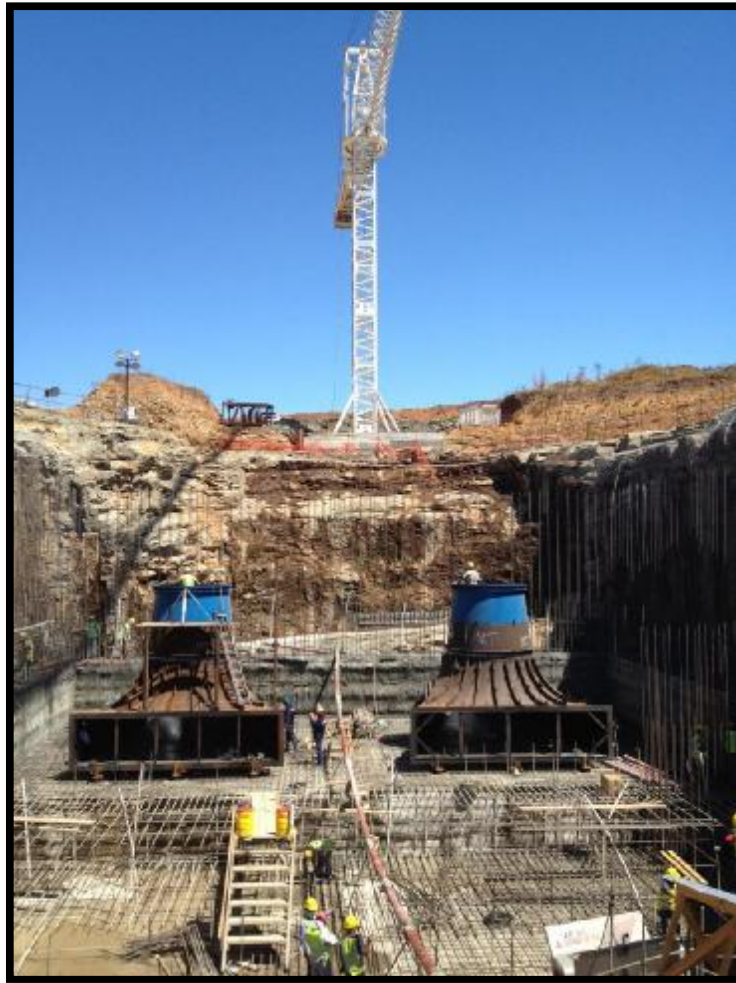
Imagen 4. Sobrecarga estática ejercida por la torre grúa, casa de máquinas, PHSL
