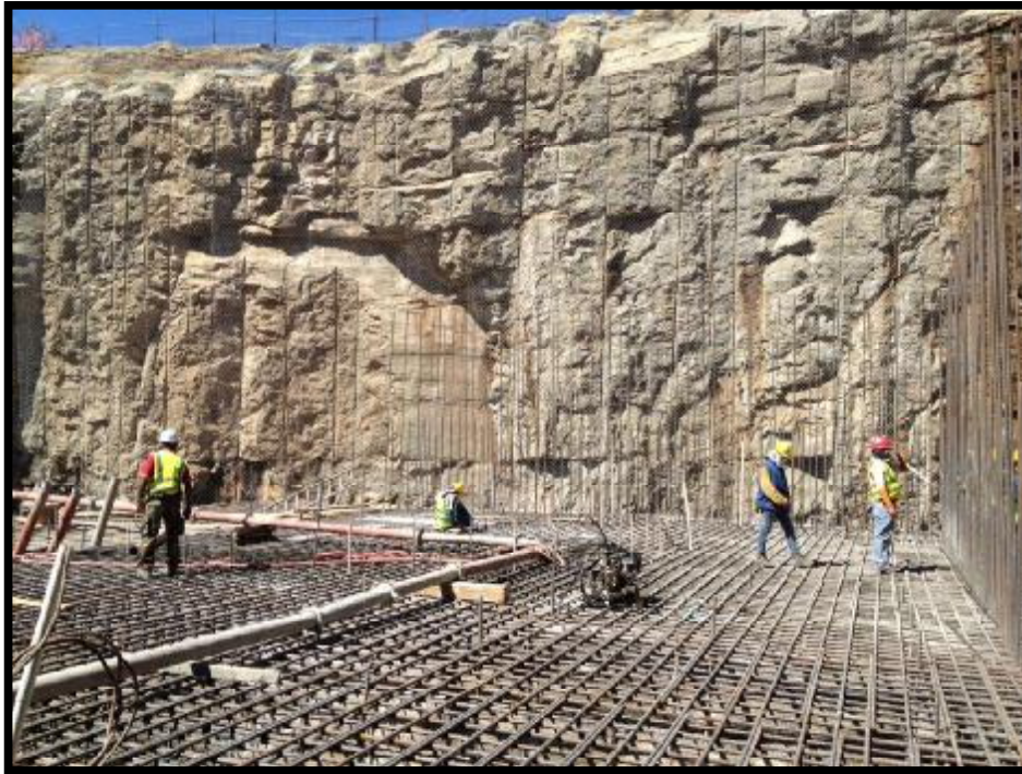
Imagen 3. Excavación en roca, casa de máquinas, PHSL
