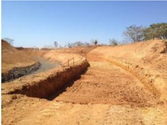
Figura 2. Vista general de excavación del canal de conducción y camino aledaño, PHSL
