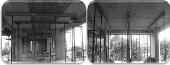
Figura 13. Colocación de puntales y formaleta para la colocación de la losa tilo. Del Autor
