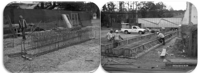
Figura 16. Proceso de fabricación de vigas prefabricadas Edificar.
