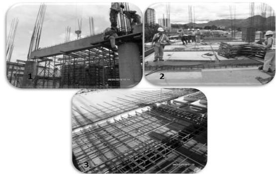
Figura 15. (1) Apuntalamiento (2) Colocación del Plywood (3) Colocación de Armadura.
