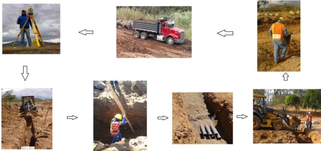
Figura 7. Esquema del ciclo general de construcción para tuberías de poca profundidad (Microsoft Power Point 2010).
