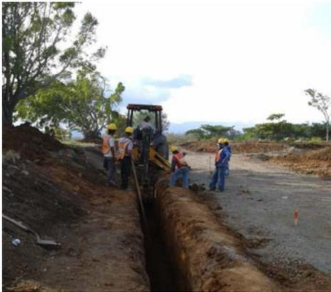
**Figura 2.** Procesos de excavación de tuberías de poca profundidad (*Microsoft Power Point 2010*).
