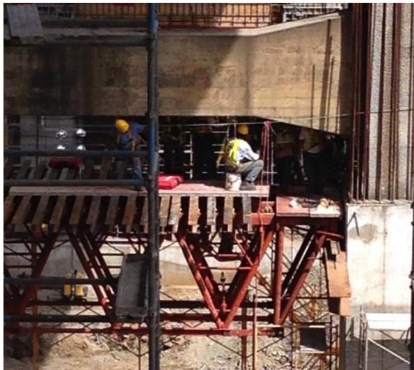
Figura 13. Encofrado y sistema de utilización de dalmines para la formaleta de fondo de viga intermedio en pila 2.
