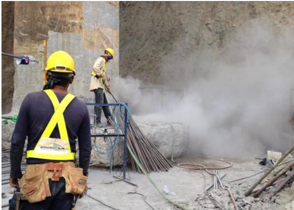
Figura 9. Proceso de limpieza en la placa de fundación de pila 3.
