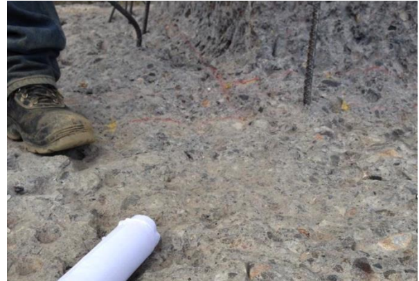
Figura 7. Trazado en la placa de fundación de pila 3.
