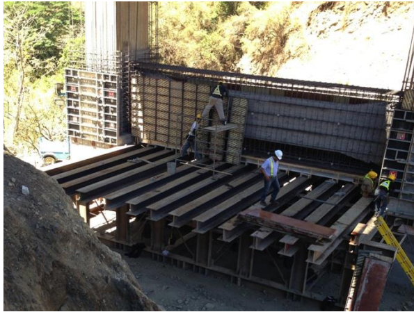
Figura 13. Encofrado y sistema de utilización de dalmines para la formaleta de fondo de viga intermedio en pila 2.
