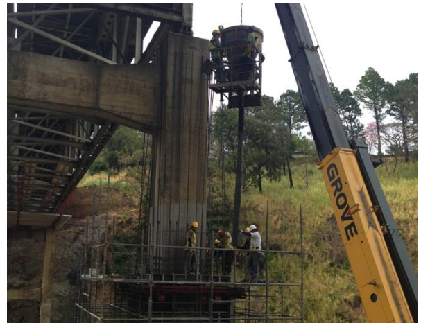
Figura 15. Colado haciendo uso del balde de grúa para una de las etapas de columna para pila 2.
