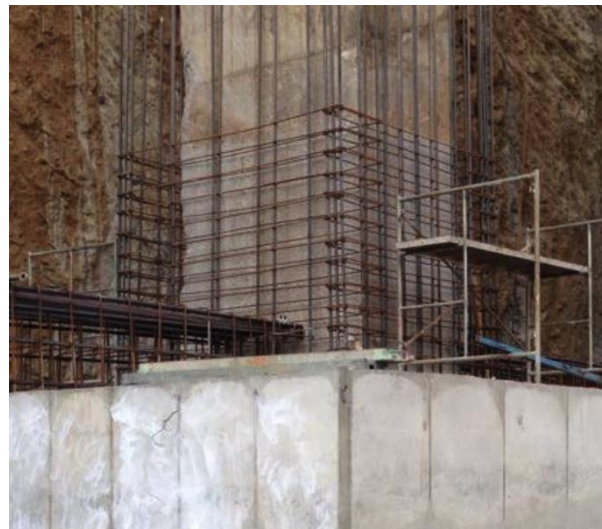
Figura 11. Proceso de armado de la primera etapa de columnas para pila 3.
