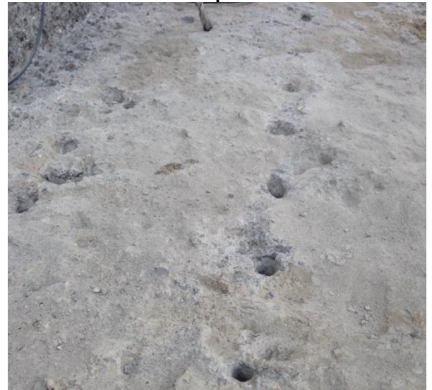
Figura 8. Perforaciones en la placa de fundación de pila 3.
