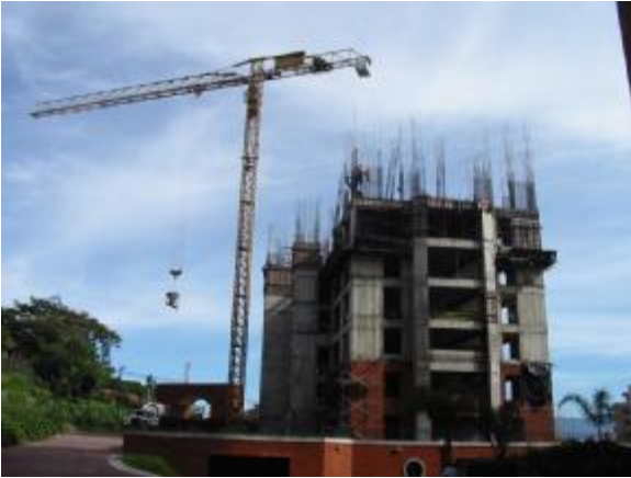
Imagen #3: Grúa torre proyecto Altos de Escazú Torre B (nivel 0+20.70m, sexto entrepiso).
