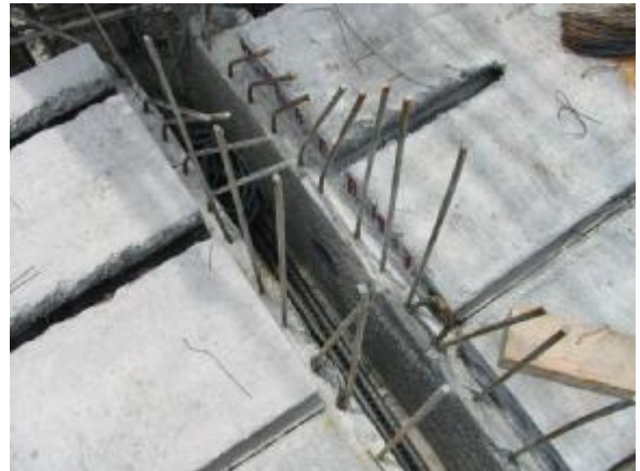
Imagen #7: Losas multitubulares montadas sobre viga de carga.
