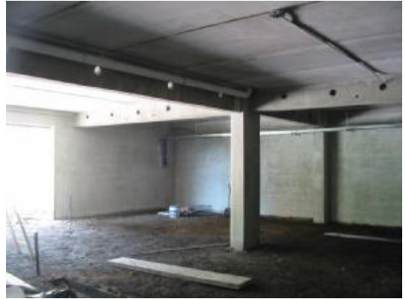
Imagen #6: Acabado final de sistema Horizontal a Flexión.
