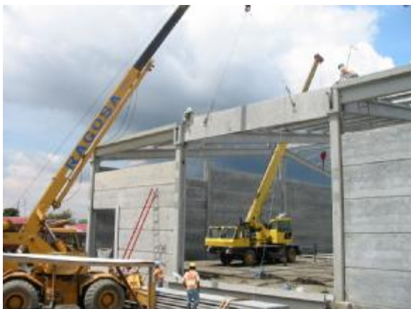
Imagen #12: Montaje de panel de cerramiento, atrás montaje de largueros.
