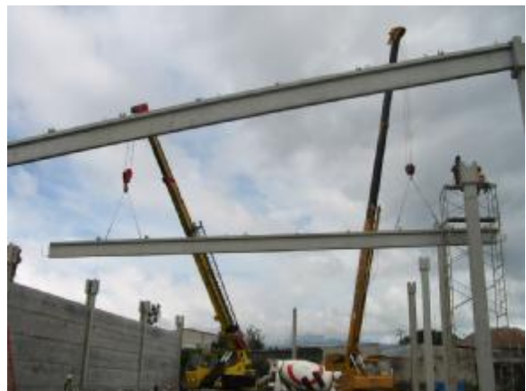
Imagen #10: Montaje de viga cercha con dos grúas móviles.
