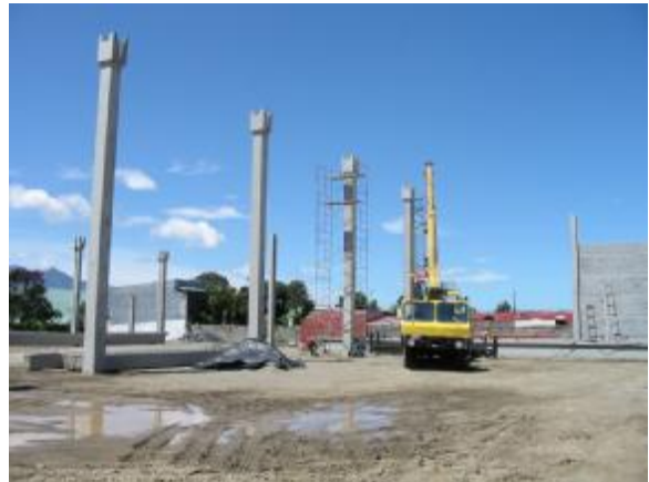
Imagen #9: Montaje de columnas principales.
