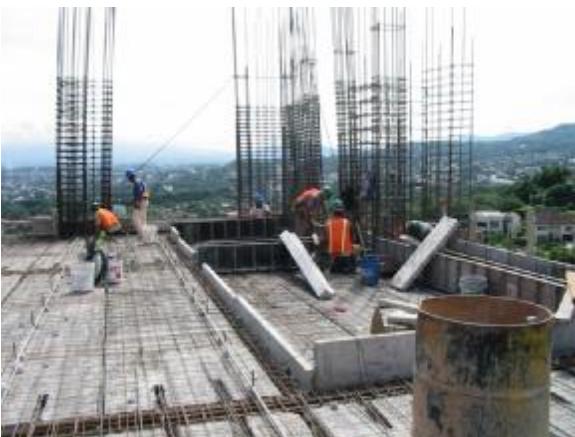
Imagen #5: Losas multitubulares de entrepiso instaladas.
