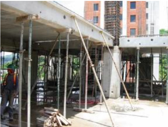
Imagen #4: Apuntalamiento de vigas de carga y vigas de amarre.
