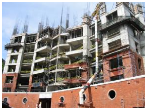
Imagen #8: Proceso de construcción en nivel 0+24.15m (séptimo nivel de entrepiso).
