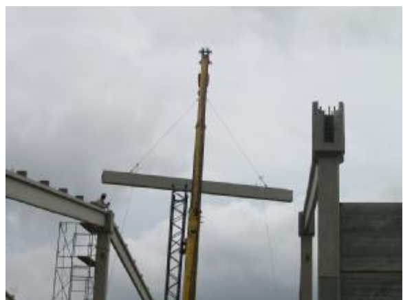
Imagen #11: Montaje de viga techo con grúa móvil.
