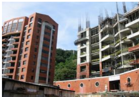
Imagen #1: Sistema Horizontal a Flexión, proyecto Altos de Escazú Torre B (en construcción nivel 6).
