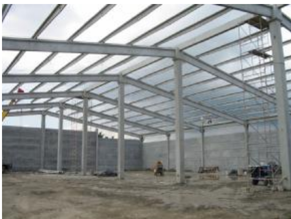
Imagen #14: Estructura principal de nave industrial.
