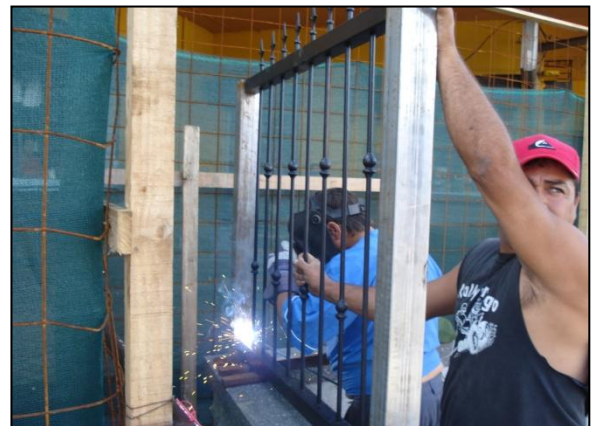
Figura 7. Cuadrilla encargada de la instalación de las verjas Fuente: tomada por el autor
