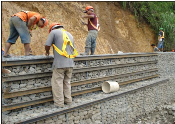
Figura 4. Cuadrilla encargada de la confección de gaviones Fuente: tomada por el autor
