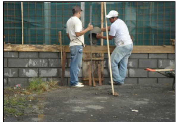
Figura 6. Cuadrilla encargada de la instalación de las verjas Fuente: tomada por el autor
