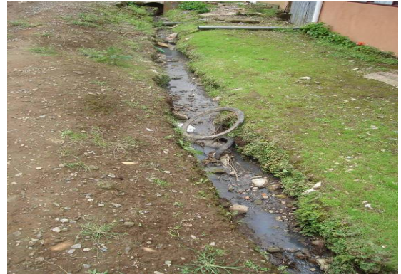
Fotografía 2. Cuneta natural junto a la calle, donde circulan las aguas grises y las aguas pluviales. Además se denotan residuos de diversos tipos
