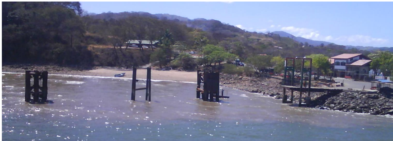
Figura 23. Terminal de Cabotaje de Playa Naranjo (Fuente: del Autor)
