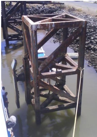
Figura 89. Duques de alba de la Terminal de Puntarenas (Fuente: del Autor)
