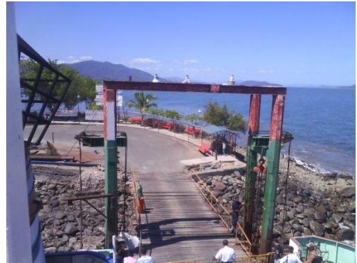
Figura 27. Ingreso a la rampa de acceso de la terminal (Fuente: del Autor)
