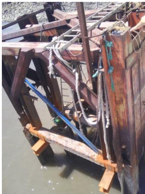
Figura 37. Reparación de emergencia en duque de alba extremo. (Fuente: del Autor)
