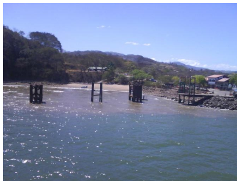
Figura 1. Terminal de Transbordadores de Playa Naranjo (Fuente: del Autor)
