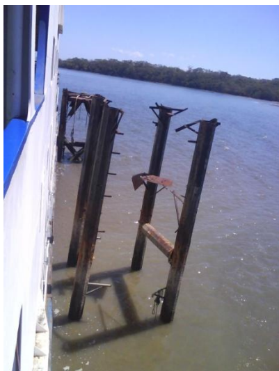
Figura 36. Duque central que no fue terminado. (Fuente: del Autor)
