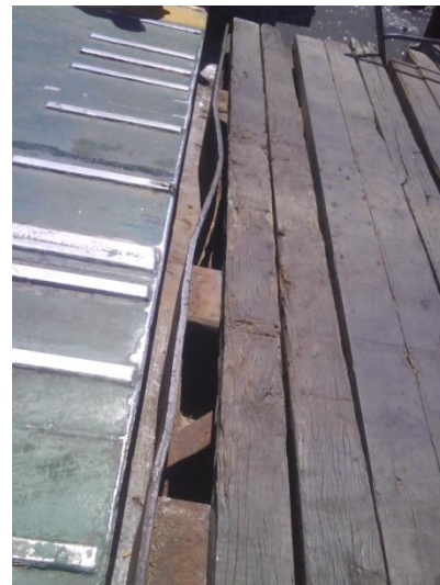
Figura 31. Detalle de los tabloncillos de rampas de acceso. (Fuente: del Autor)
