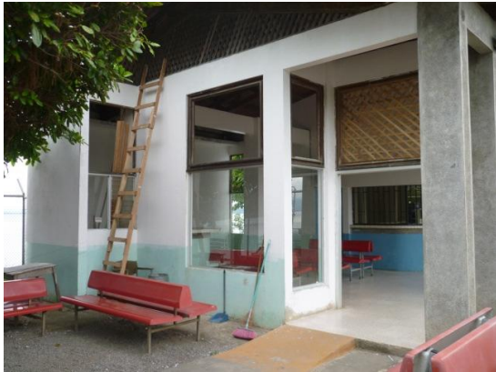
Figura 29. Vista general del edificio. (CCM, 2011)
