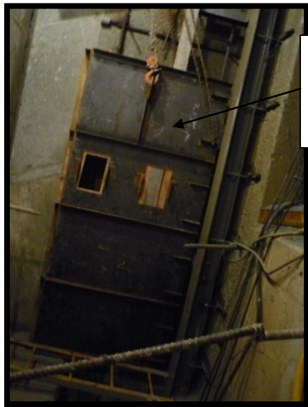
Figura 9. Formaleta metálica utilizada para el colocado de los concretos de 2° etapa en los nichos de las compuertas
