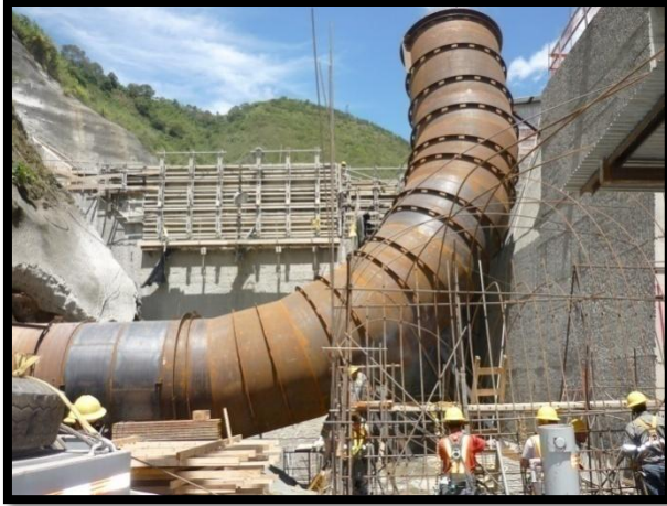
Figura 2. Codo circular de la tubería de blindaje, es la unión de la toma de aguas con la tubería del túnel de conducción.
