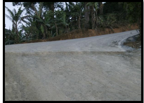
Figura 20. Camino con la superficie de rodamiento acondicionada con RCC y ampliación de curva.
