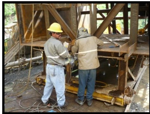
Figura 18. Soldadores calificados trabajando en la unión de elementos metalmecánicos.
