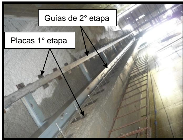
Figura 3. Guías de 2° etapa, instaladas sobre las placas de 1° etapa, sobre ellas se deslizará la compuerta vagón.
