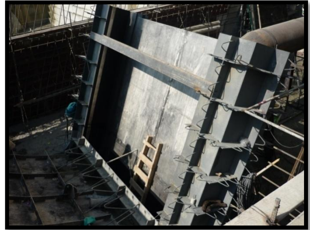
Figura 4. Nicho blindado ubicado por encima de la embocadura, será la zona donde la compuerta de la toma de agua descansará mientras esta se encuentre levantada para que el agua fluya por la embocadura.
