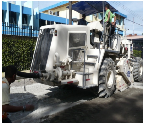
Figura 19. Equipo empleado para estabilizar la base en sitio (Fuente: El autor)
