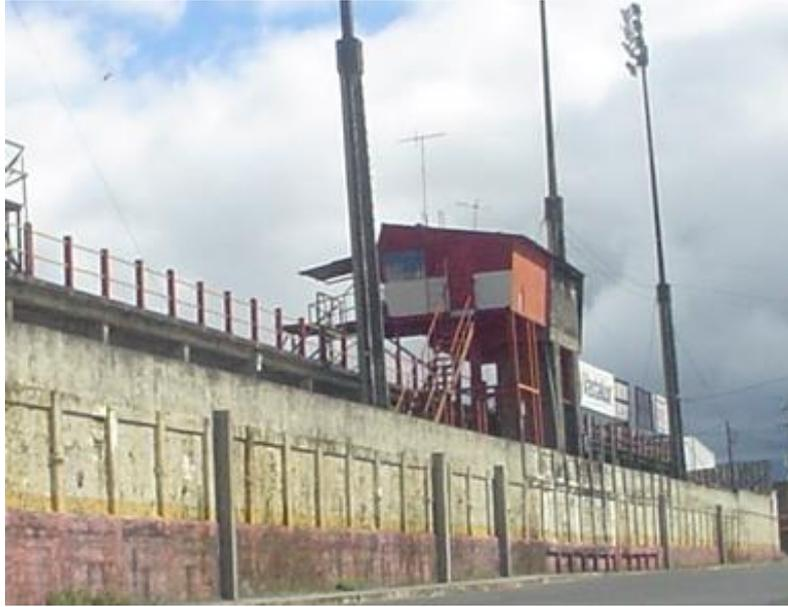
Figura 19. En esta foto se presentan los tres casos en análisis, las casetillas de transmisión de mampostería y perling ubicadas en el centro y la presión del terreno en el resto del muro, descartando la aplicación de carga por parte de las torres y las graderías como se comprobó anteriormente.
