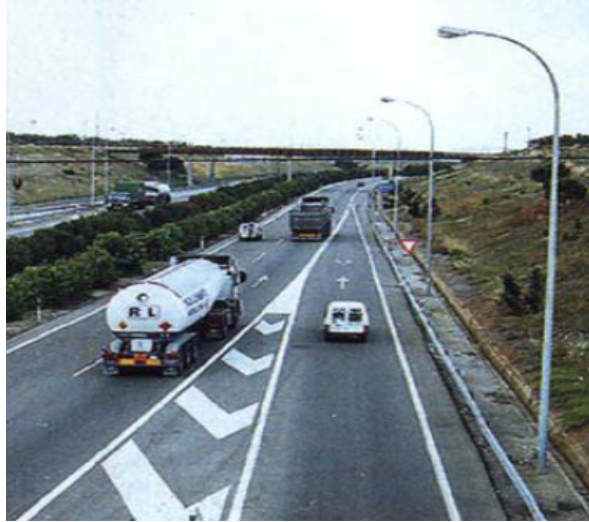
Figura 9. Detalle de carril de desaceleración. (Fuente: Bañon, L. Bevia, J. 2000. MANUAL DE CARRETERAS VOLUMEN 1, ELEMENTOS-PROYECTO. Universidad de Alicante. 4c-10p.
