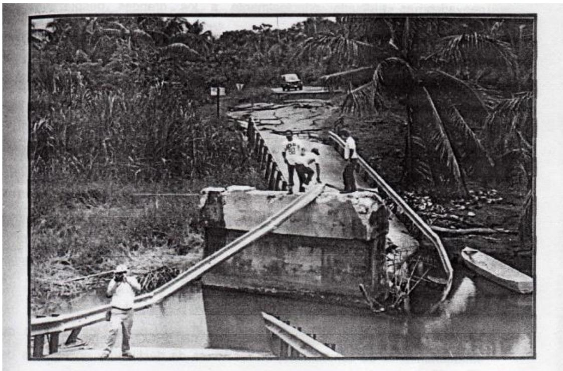
Figura 57. Puente sobre el río Bananito colapsado (terremoto de Limón 1991), (Mauricio Batalla, 2002).
