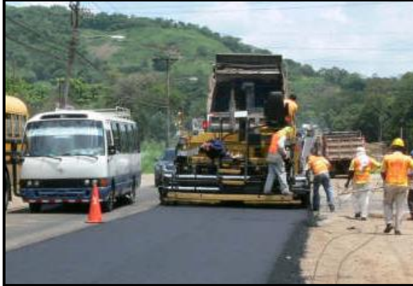
Figura 4. Colocación de mezcla asfáltica en caliente
