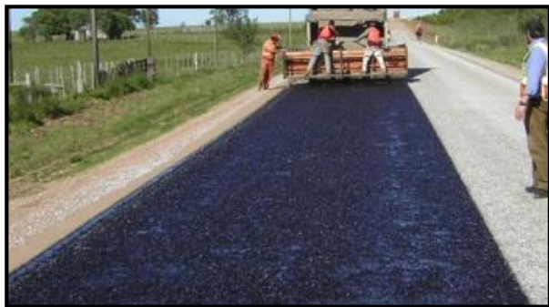
Figura 3. Tratamiento de base mediante ligantes bituminosos
