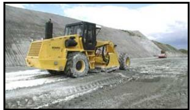
Figura 2. Mezcla de cemento portland con material granular para la fabricación de base estabilizada con cemento
