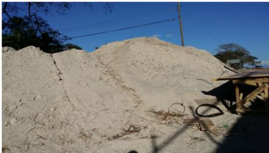
Fotografía 10. Zona de corte de materiales en el proyecto sobre la intersección de Bagaces
