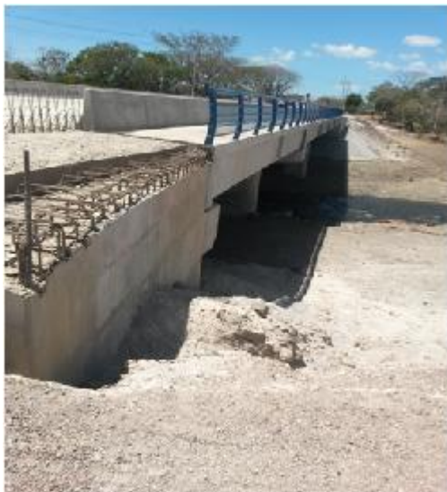
Fotografía 1. Costado norte del puente sobre el río Corobici
