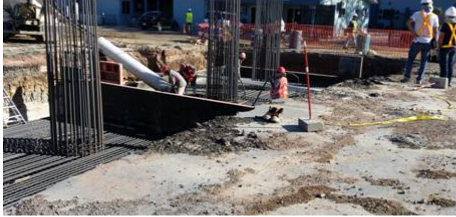
Fotografía 11. Construcción del intercambiador sobre la intersección de Bagaces
