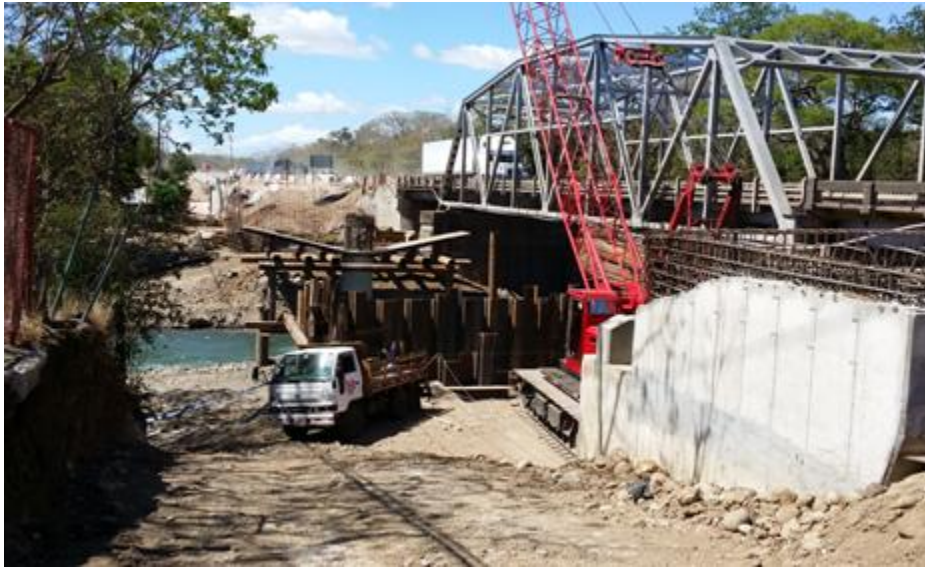
Fotografía 5. Costado sur del puente sobre el río Corobicí
