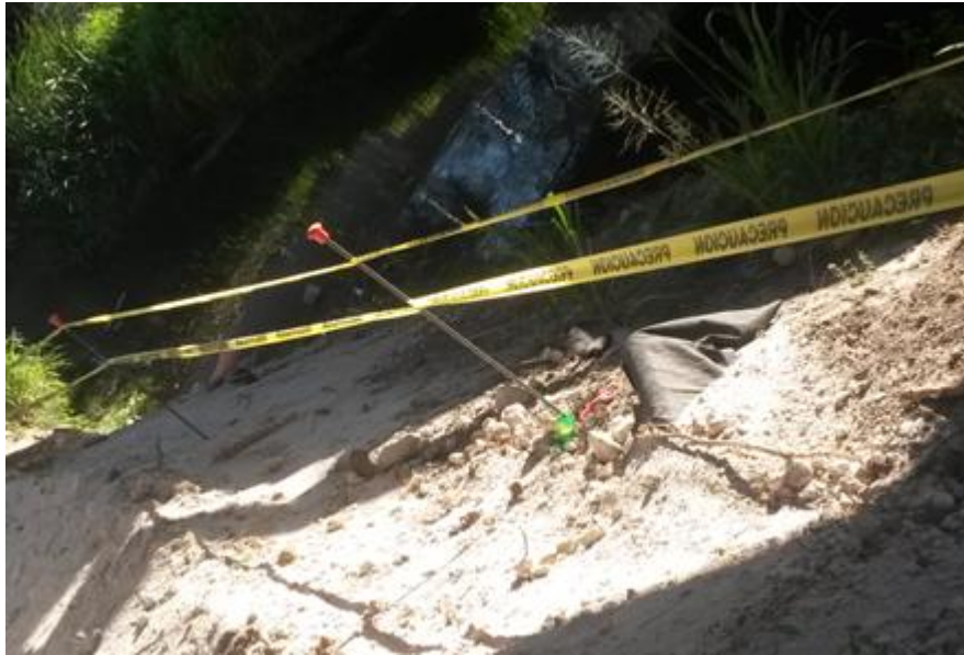
Fotografía 13. Quebrada perteneciente al proyecto sobre la intersección de Bagaces
