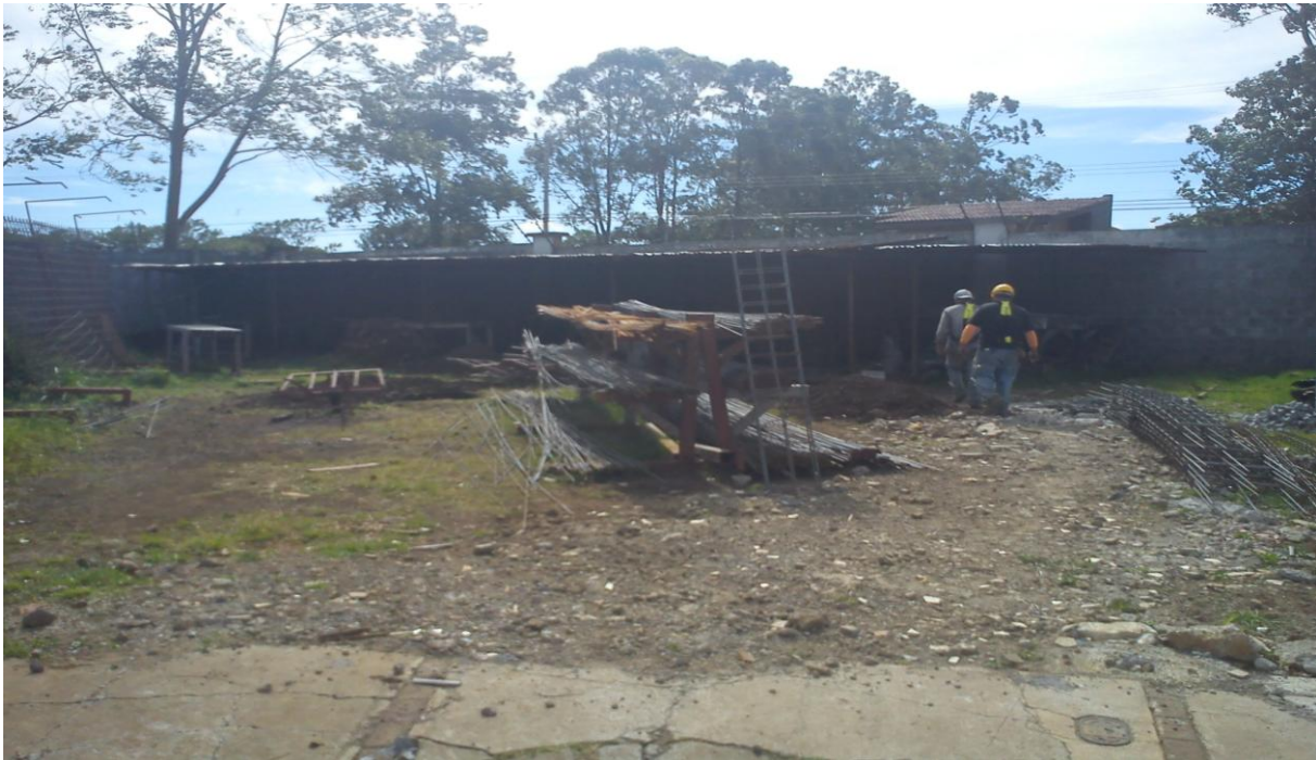
Figura N° 2. Taller de Armado de Estructuras- Lote 10-A. Marzo, 2014.
