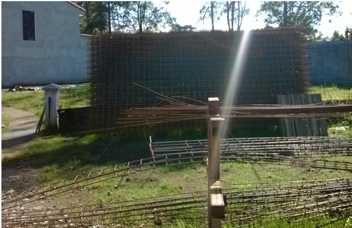
Figura N°22.Malla electro – soldada, Lote 10 a .Marzo, 2014
