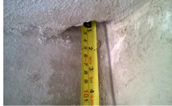
Figura N°39. Relleno del cielo en la Casa 17-A
