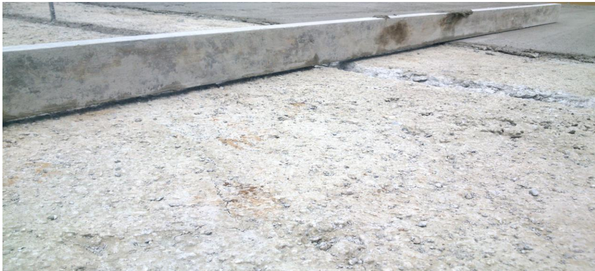
Figura N°37. Proceso de Nivelación de pisos.
