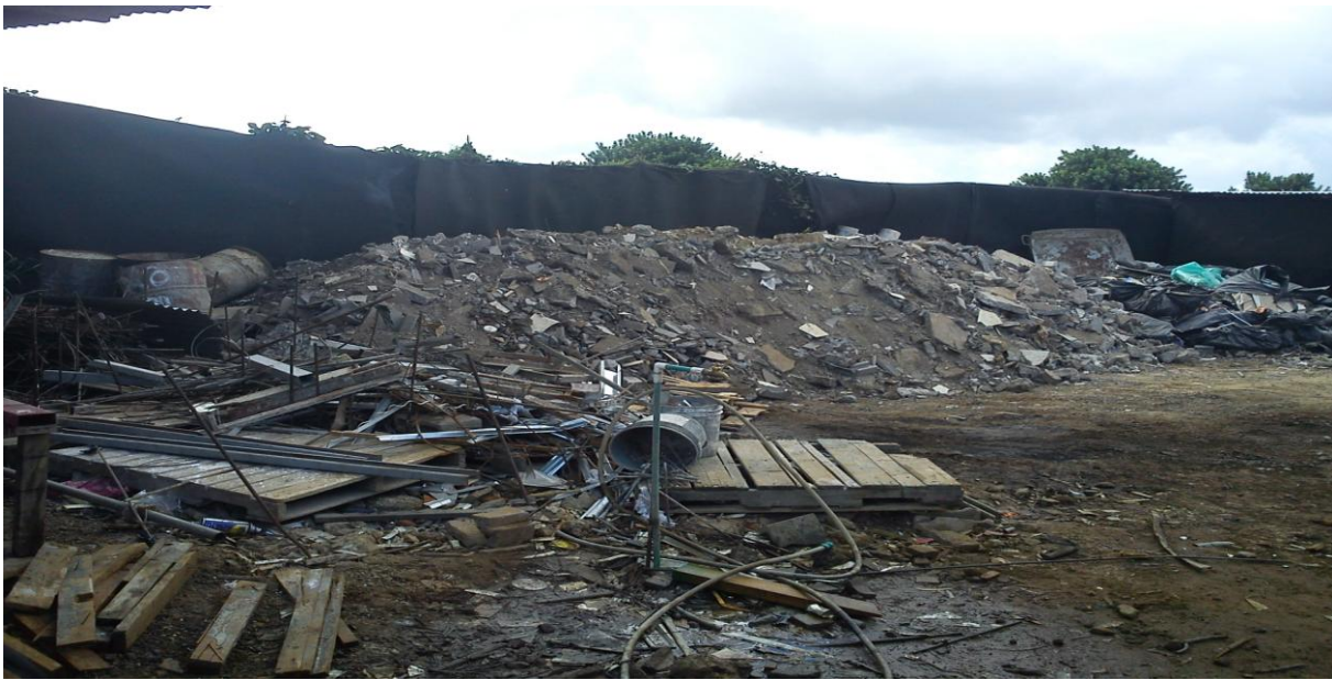
Figura N° 7. Área de bodega de materiales – Área de escombros. Marzo, 2014.
