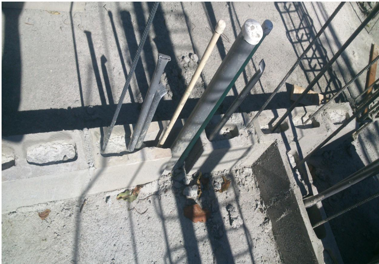
Figura N°35. Block cortado en la primera hilada.
