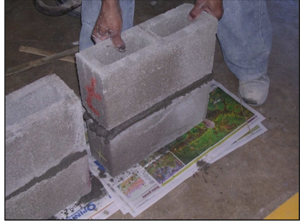
Imagen 10. Fabricación de prismas de mampostería
