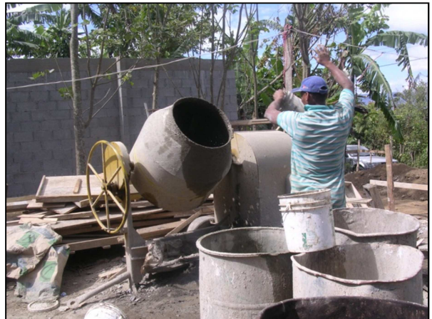
Imagen 32. Elaboración de la mezcla de mortero en sitio
