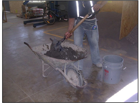
Imagen 6. Albañil fabricando la mezcla para prismas de mampostería
