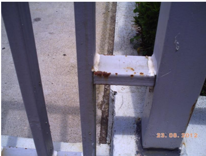
Figura 6. Deterioro por uniones en el elemento.
