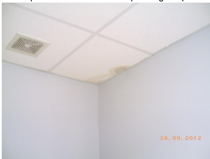
Figura 3. Láminas sucias por gotera.
