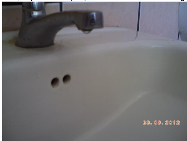
Figura 13. Grifo con gotera evidente.
