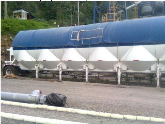
Figura 6. Silo móvil o marrana para almacenamiento de cemento, planta Pozzuolli P.H.R.
