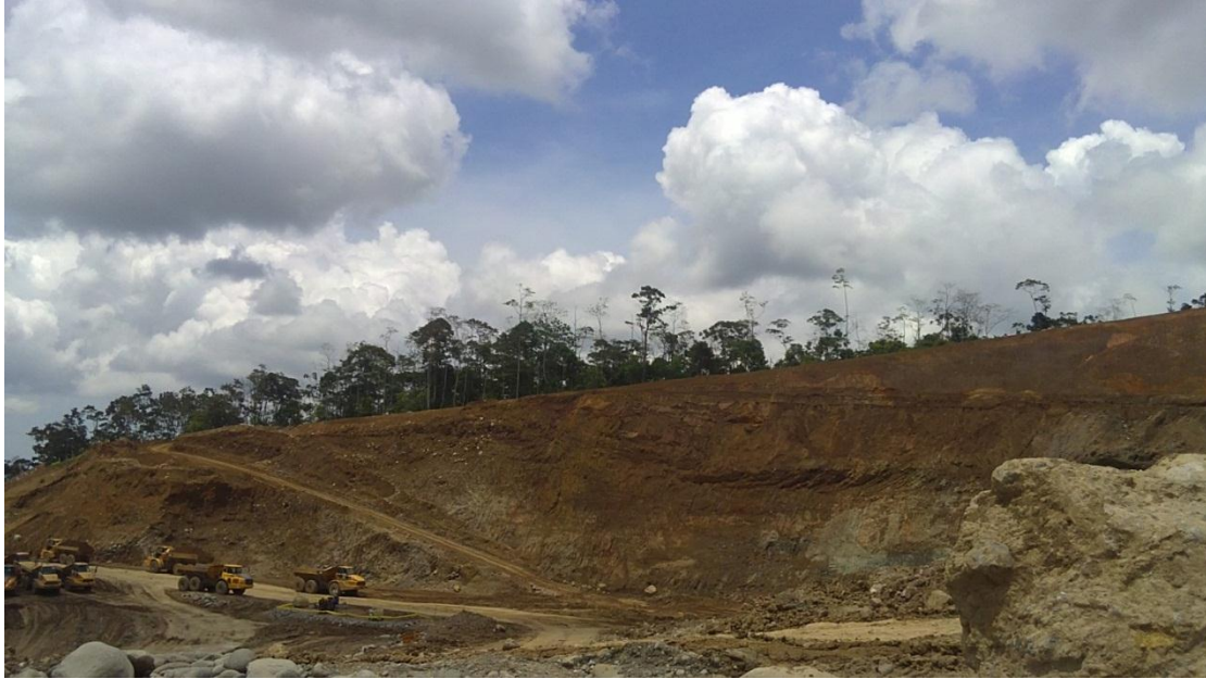
Figura 28. Excavaciones en el vertedor, P.H.R.
