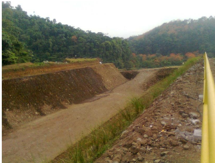
Figura 31. Excavación para tubería de conducción, P.H.R.
