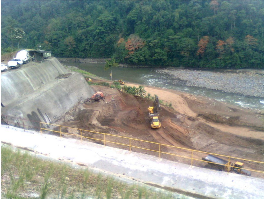
Figura 32. Sitio de ubicación Casa de máquinas, P.H.R.
