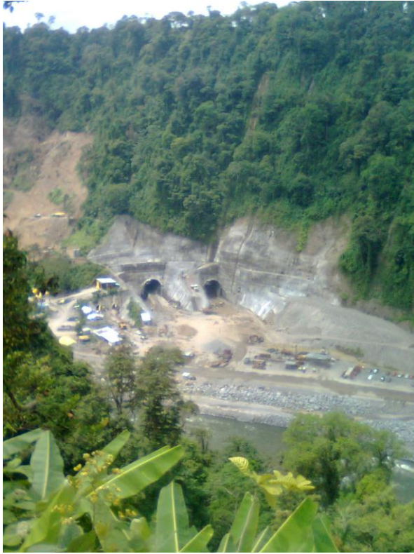
Figura 27. Final túneles de desvío, P.H.R.
