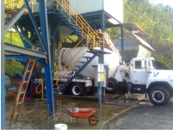
Figura 15. Descarga del concreto en camión automezclador planta Pozzuolli P.H.R.
