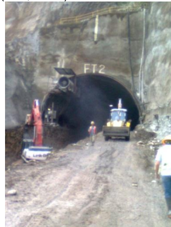
Figura 26. Final túnel 2 de desvío, P.H.R..
