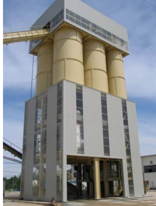
Figura 4. Planta de acopio vertical. Tomado de www.talleresalquezar.es
