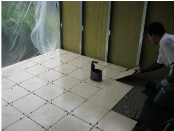
Fotografía 22. Instalación del piso cerámico
