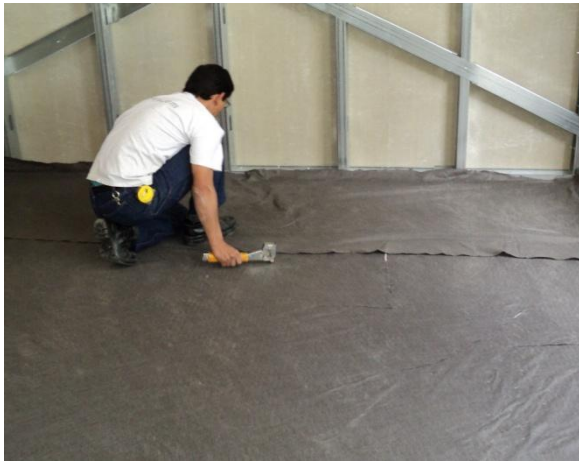
Fotografía 3. Zona de traslape del geotextil
