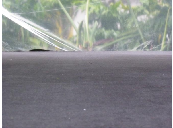
Fotografía 21. Geotextil adherido a la lámina Plystone
