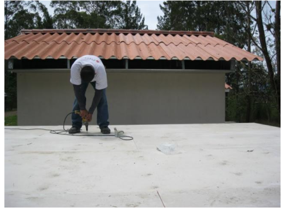
Fotografía 26. Fijación de las láminas
