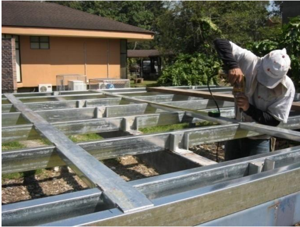
Fotografía 18. Instalación de la estructura de soporte
