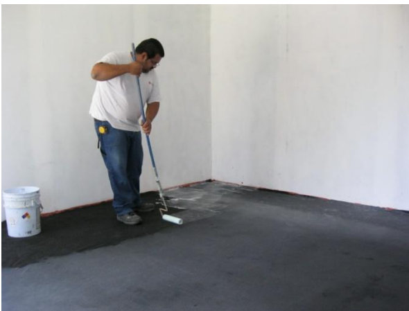
Fotografía 14. Colocación de pegamento sobre el geotextil
