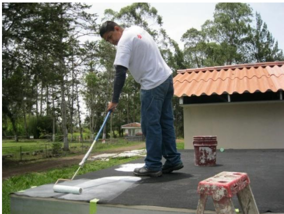
Fotografía 27. Adherencia del geotextil
