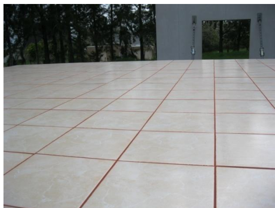
Fotografía 29. Acabado Final Prueba 5
