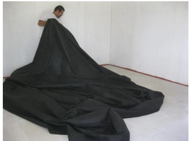
Fotografía 13. Colocación de geotextil
