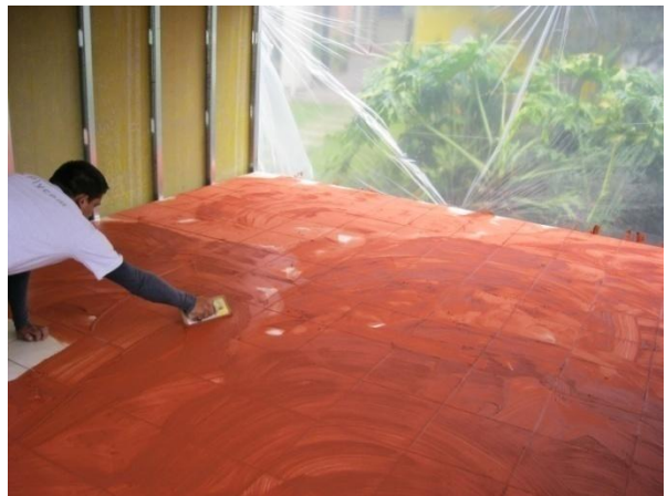
Fotografía 23. Colocación de fragua
