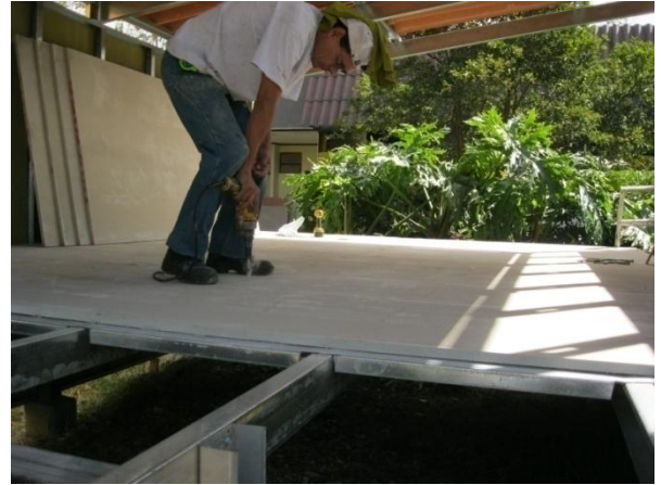
Fotografía 19. Fijación de las láminas
