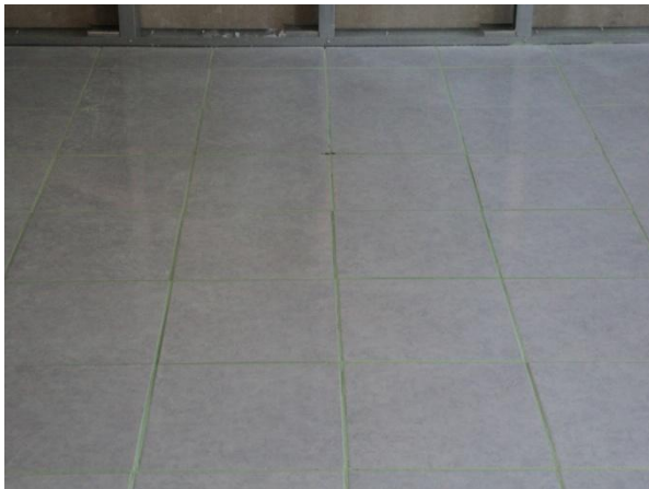
Fotografía 7. Acabado final prueba 1
