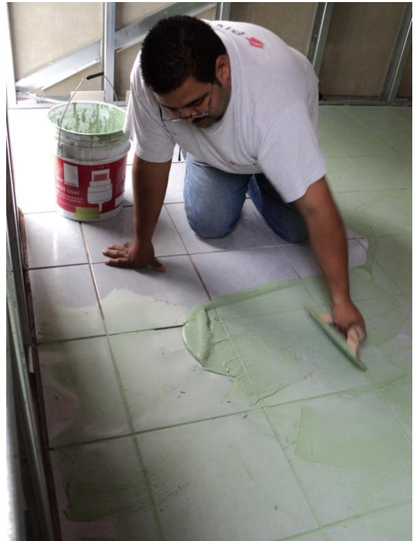
Fotografía 6. Colocación de fragua
