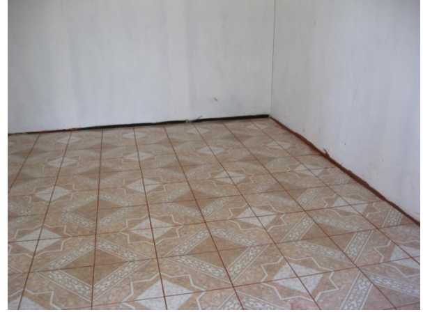
Fotografía 17. Acabado final de la prueba 3
