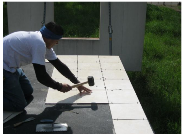
Fotografía 28. Instalación del piso cerámico
