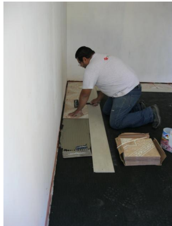
Fotografía 15. Instalación de piso cerámico
