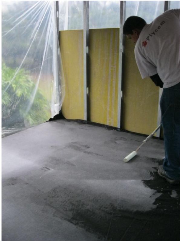
Fotografía 20. Colocación de pegamento sobre el geotextil
