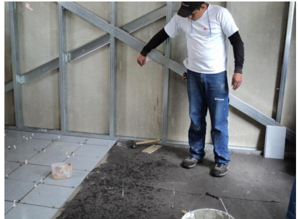
Fotografía 4. Remojo del geotextil
