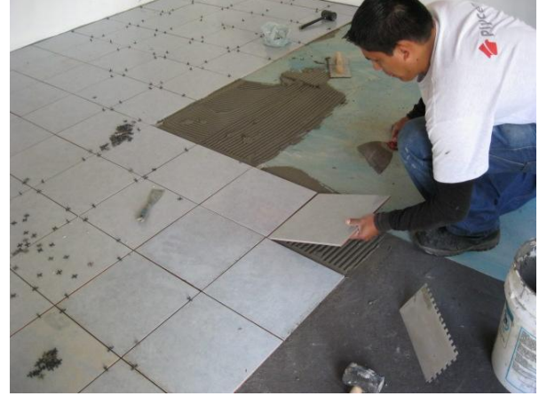
Fotografía 9 Colocación de cerámica sobre el área con geotextil
