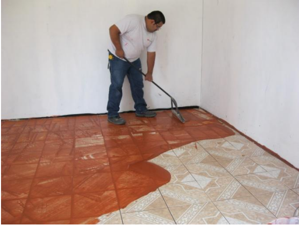
Fotografía 16. Distribución de la fragua sobre el área de piso.
