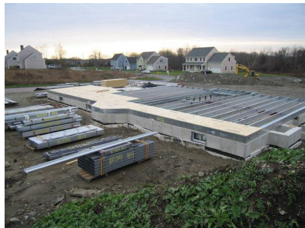
Figura 11. Construcción de entresado realizada en Estados Unidos (Tomado de: American Steel Frame Services)
