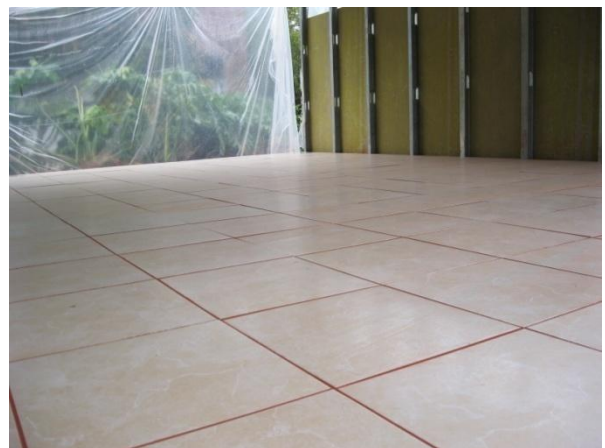
Fotografía 24. Acabado Final prueba 4
