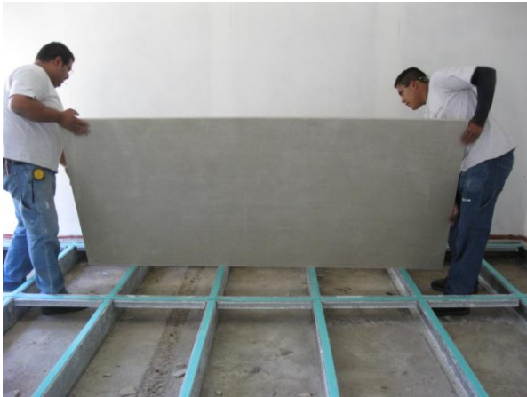
Fotografía 12. Instalación de láminas sobre perfiles
