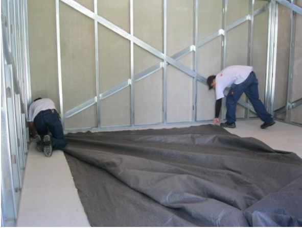
Fotografía 1. Colocación del geotextil
