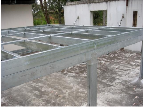
Fotografía 25. Detalle de la estructura de soporte
