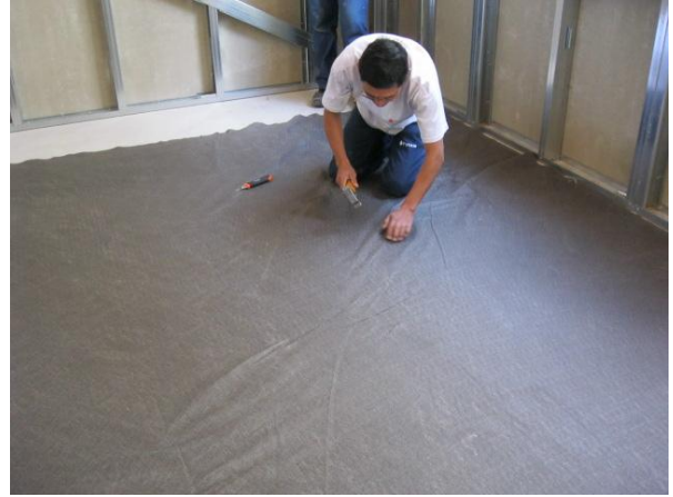
Fotografía 2. Fijación del geotextil mediante grapas
