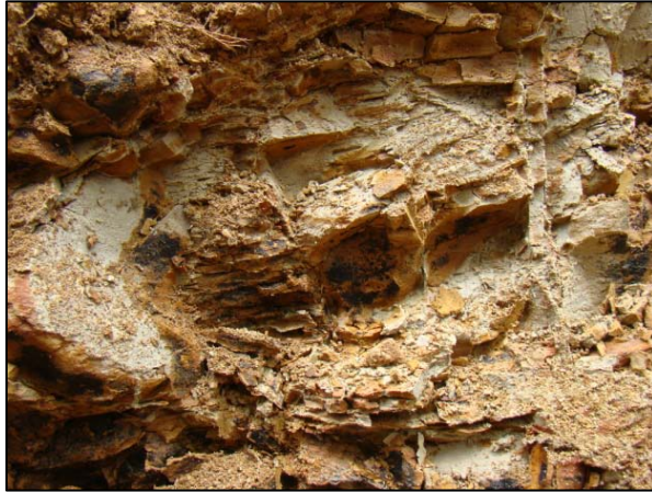
Figura 27. Detalle de pared Norte, estratificación y fracturas (Jiménez & López, 2009).
