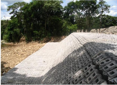
Figura 37. Protección de talud. 23
