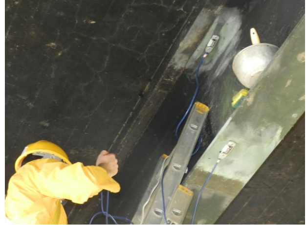
Figura 64. Preparación para la instalación de sensores
