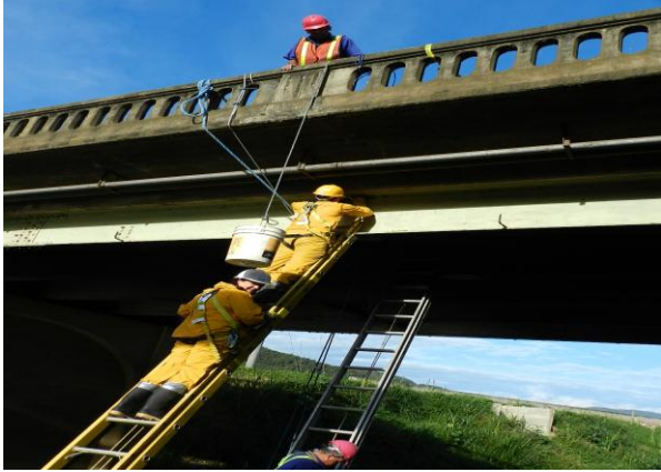
Figura 44. Líneas de vida y arneses de seguridad durante la prueba.
