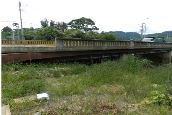
Figura 20. Vista Lateral del Puente.
