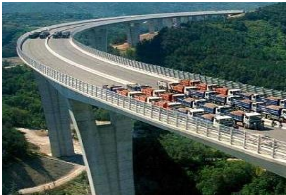
Figura 28. Ejemplo de pruebas de carga en puentes en Sydney.
