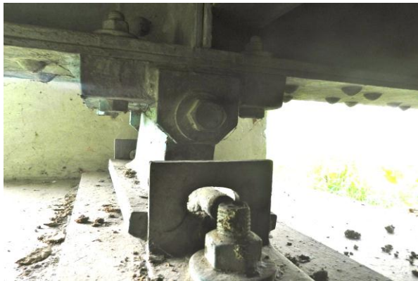
Figura 21. Apoyo expansivo, tipo balancín.
