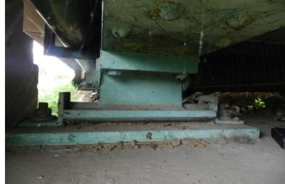
Figura 26. Rotaciones en apoyos.
