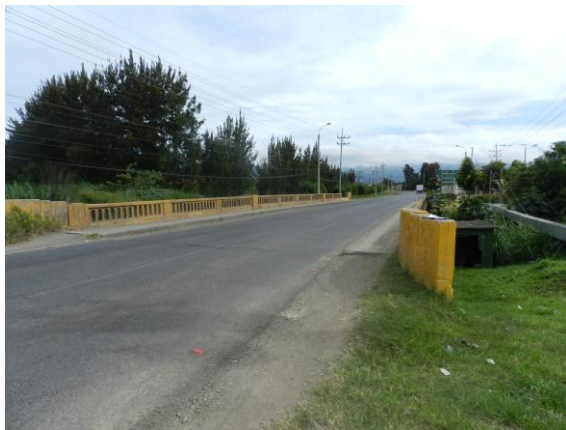
Figura 15. Puente sobre el Río Purires
