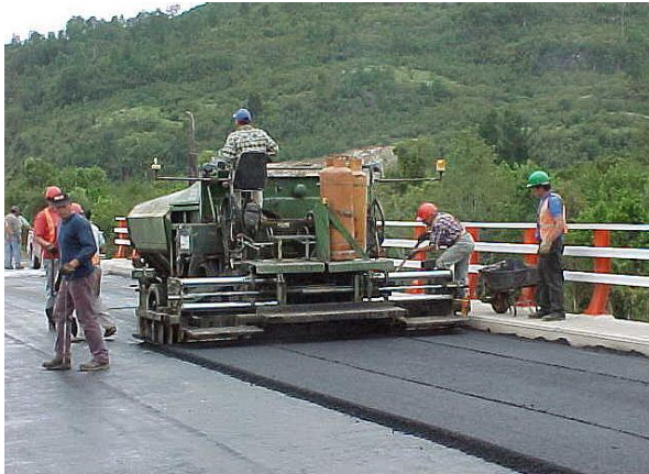
Figura 7. Superficie de ruedo, Puente Calcurrupe.
