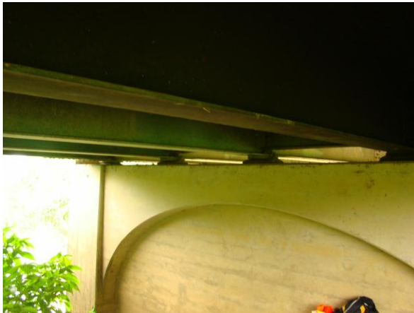
Figura 17. Bastión y apoyos del puente.
