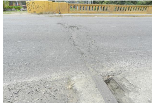
Figura 19. Carpeta asfáltica y juntas de expansión.
