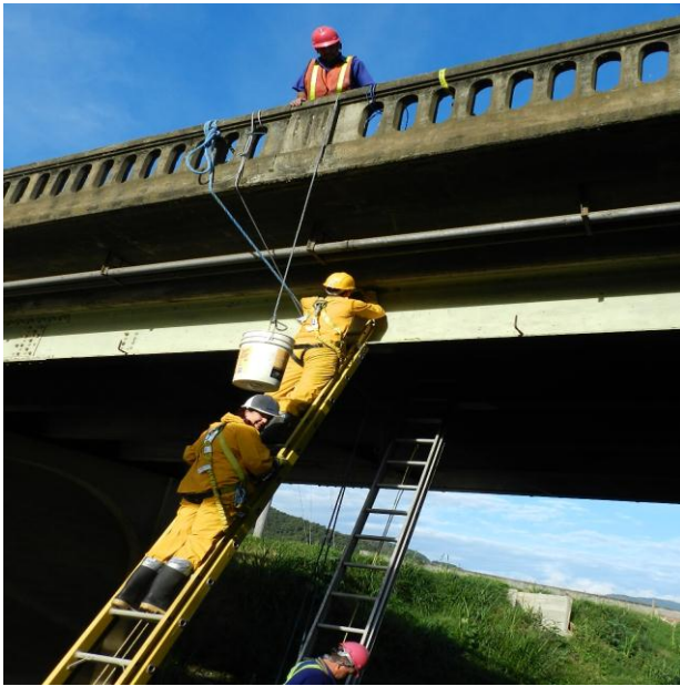
Figura 63. Preparación para la instalación de sensores.
