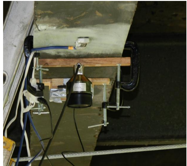
Figura 65. Viga totalmente sensoreada.
