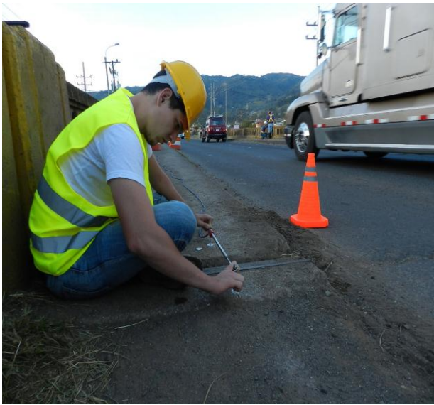
Figura 67. Instalación de sensores en Juntas de expansión.
