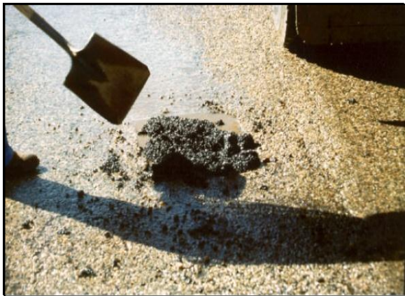
Figura 46. Colocado de material (FHWA, 1999)
