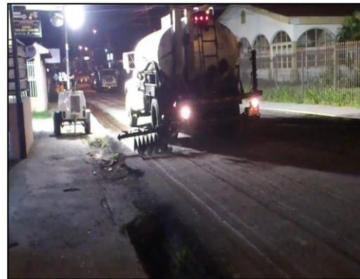
Figura 79. Riego mecanizado de emulsión asfáltica (Autor, 2012)
