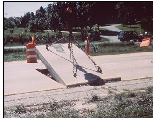
Figura 87. Remoción de material en pavimentos rígidos. (FHWA, 2012)
