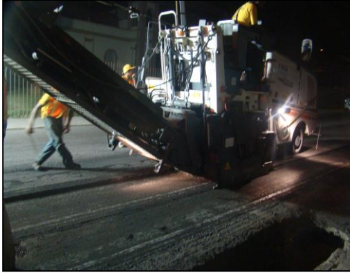
Figura 72. Remoción material dañado utilizando perfiladora (Autor, 2012).
