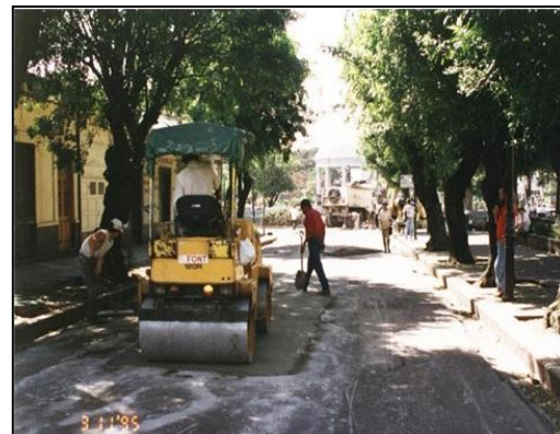
Figura 91. Compactación de concreto tipo CCR (ICCYC, 1995)
