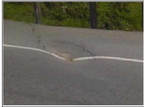
Figura 21. Hundimiento (INVIAS,2006)
