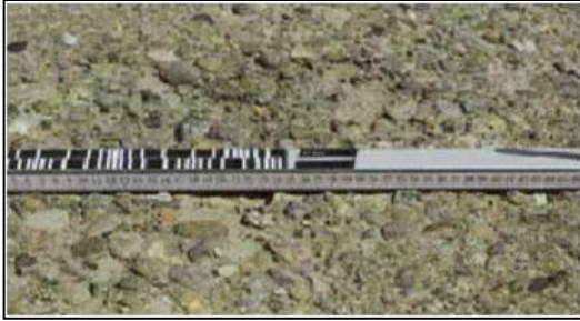
Figura 23. Peladura (SIECA,2000)
