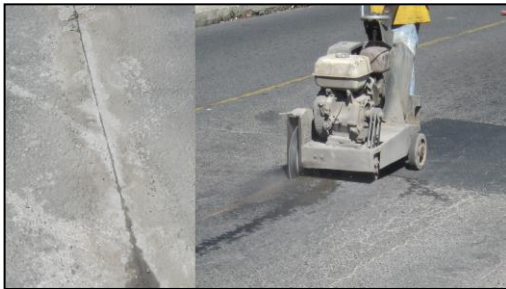
Figura 69. Cortes en área a bachear (Autor, 2012)
