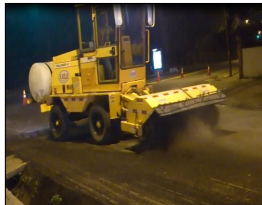
Figura 76. Limpieza mecanizada de bache.( Autor,2012)
