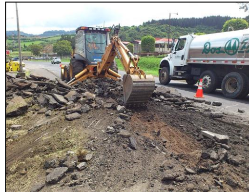
Figura 71. Remoción material dañado utilizando back-hoe (Autor, 2012)
