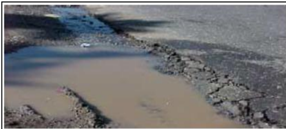
Figura 24. Desintegración de bordes (INVIAS,2006)
