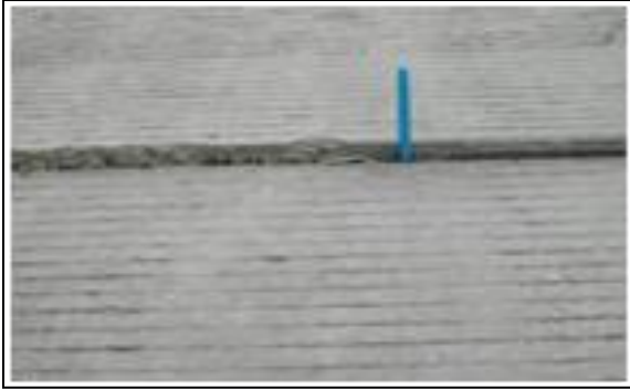
Figura 35. Escalonamiento (SIECA, 2010)
