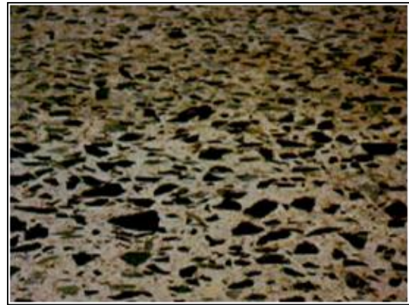
Figura 42. Pulimiento (SIECA, 2010)
