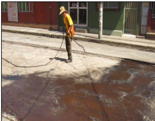
Figura 77. Riego manual de emulsión asfáltica (Autor,2012)
