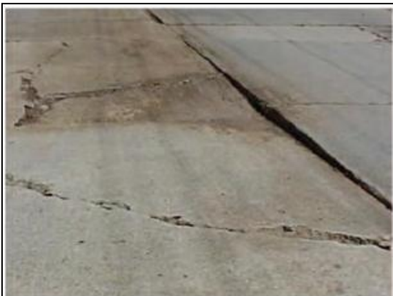
Figura 36. Hundimiento (SIECA 2010)
