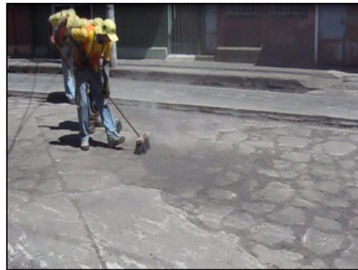
Figura 75. Limpieza manual del bache (Autor,2012).
