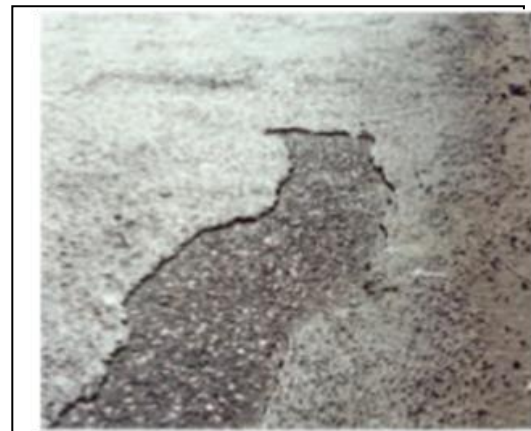
Figura 38. Peladura (SIECA,2010)
