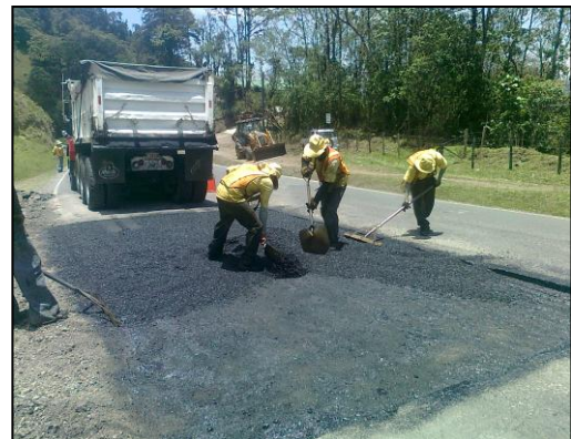
Figura 84. Colocación de mezcla asfáltica (Autor,2012)
