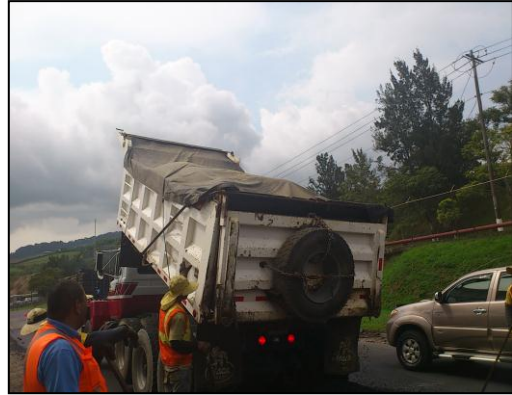
Figura 83. Vagoneta para transportar la mezcla asfáltica (Autor,2012)
