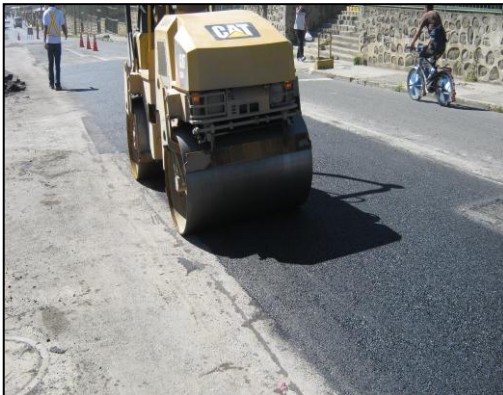
Figura 85. Procedimiento de compactación (Autor, 2012)
