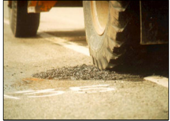
Figura 47. Procedimiento de compactación, utilizando vagoneta de volteo. (FHWA, 1999)
