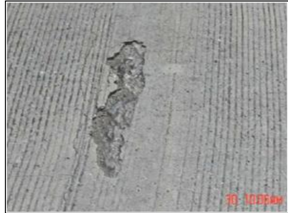
Figura 41. Descascaramiento (INVIAS, 2006)
