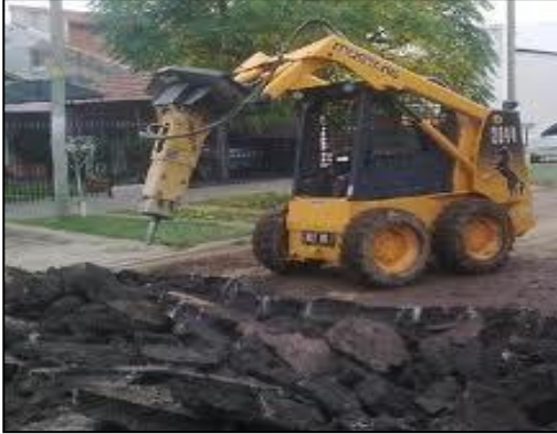
Figura 88. Remoción de material en pavimentos rígidos.
