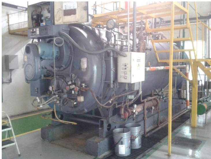
Figura 4.3. Caldera marca Cleaver Brooks de 200 BHP.
