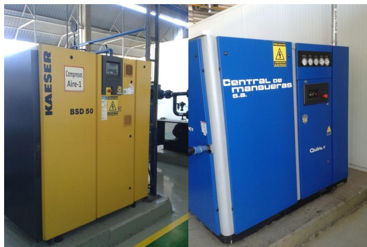
Figura 4.11. Compresores de aire a 7 Bar.
