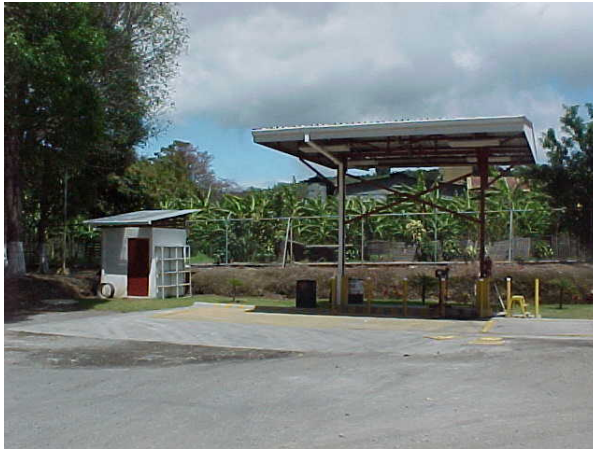
Figura 5.1 Vista Panorámica Surtidor de Diesel y Cobertizo
