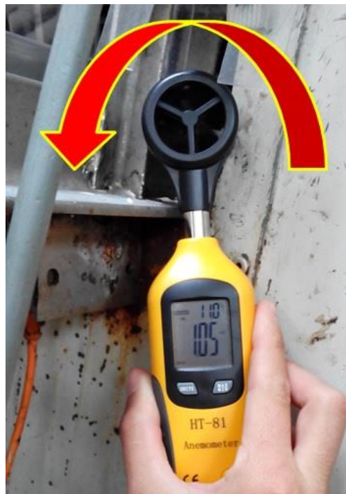
Figura. 16. Anemómetro en la entrada de aire (infiltración)
