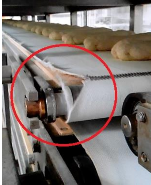
Figura. 34. Lagarto de banda dañado
